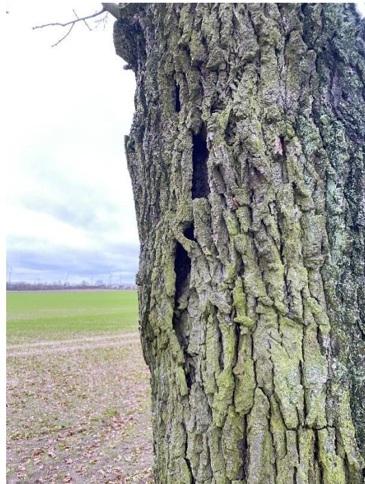
Abbildung 10: Spalten in Alleebaum - Potenzielles Käferhabitat
