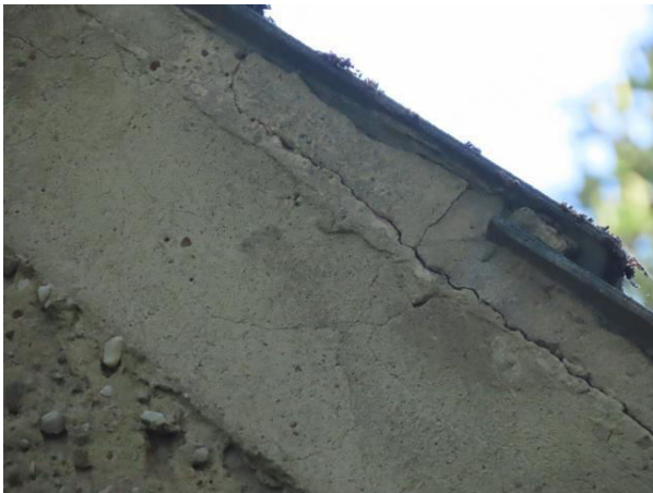
Dacheinfassung des Wohngebäudes
