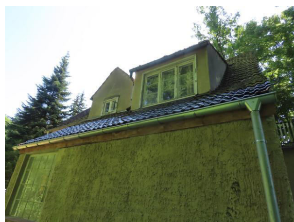
Ausgebesserter Dachbereich nach Sturmschaden
