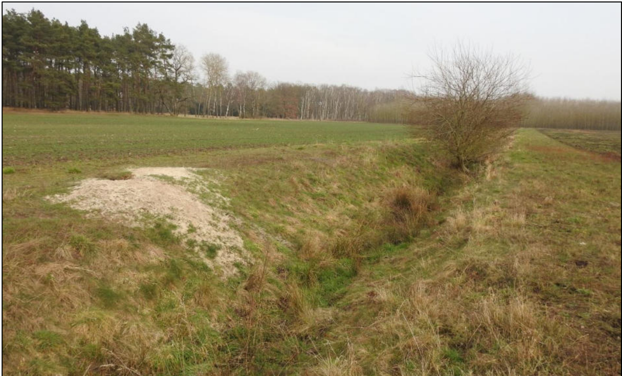
Abb. 9: Überwiegend ausgetrockneter G03 im nordwestlichen UR
