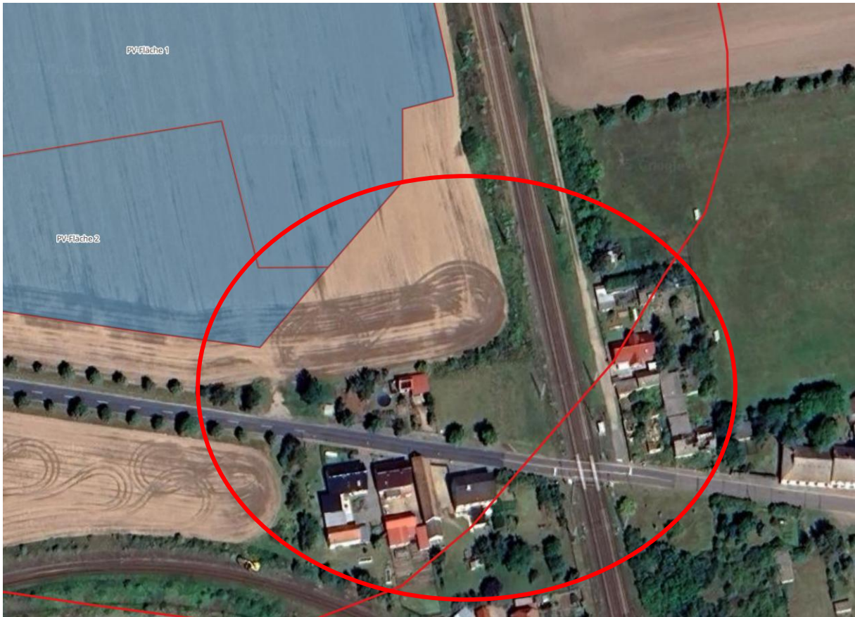
Abbildung 7: Wohngebäude in der 100-Meter-Zone - Quelle Satellitenbild: Google Earth Pro
