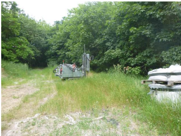
Abbildung 15: Feldarbeiten DPH 8/23 (1. Versuch)
