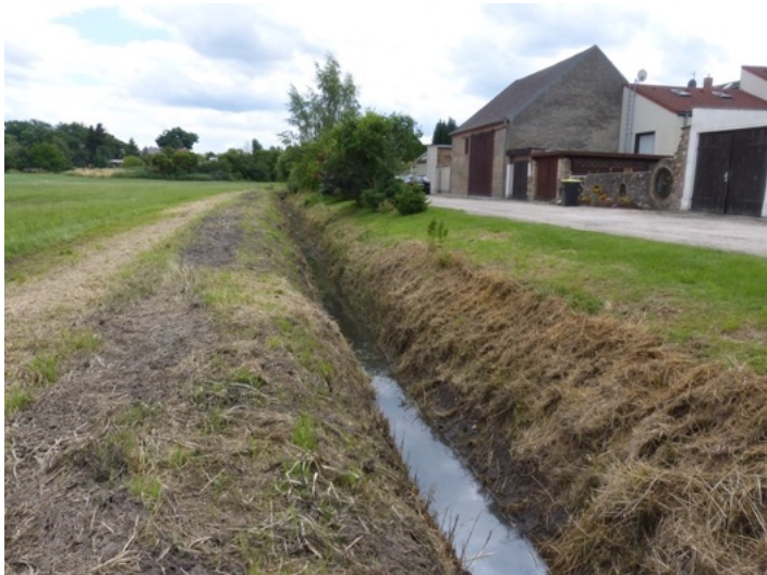
Im Juli 2023 Beräumter Graben im Plangebiet
