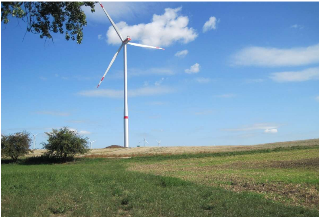
Abbildung 9: Blick vom Bandelowsee auf die WEA in dem Baufenster 1 mit zwei der drei Weißdornbüsche am Wegesrand
