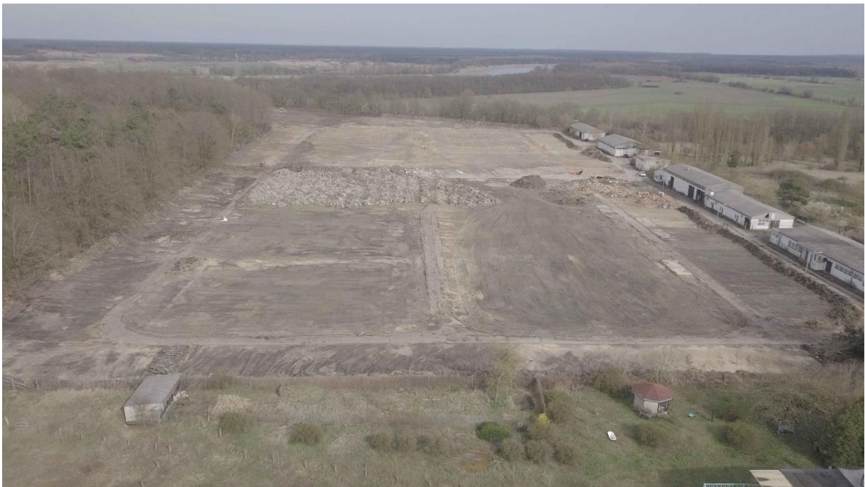
Abbildung 2: Drohnenaufnahme vom Standort, Blick nach Osten (Quelle Vorhabenträger valuteo, 2024)
