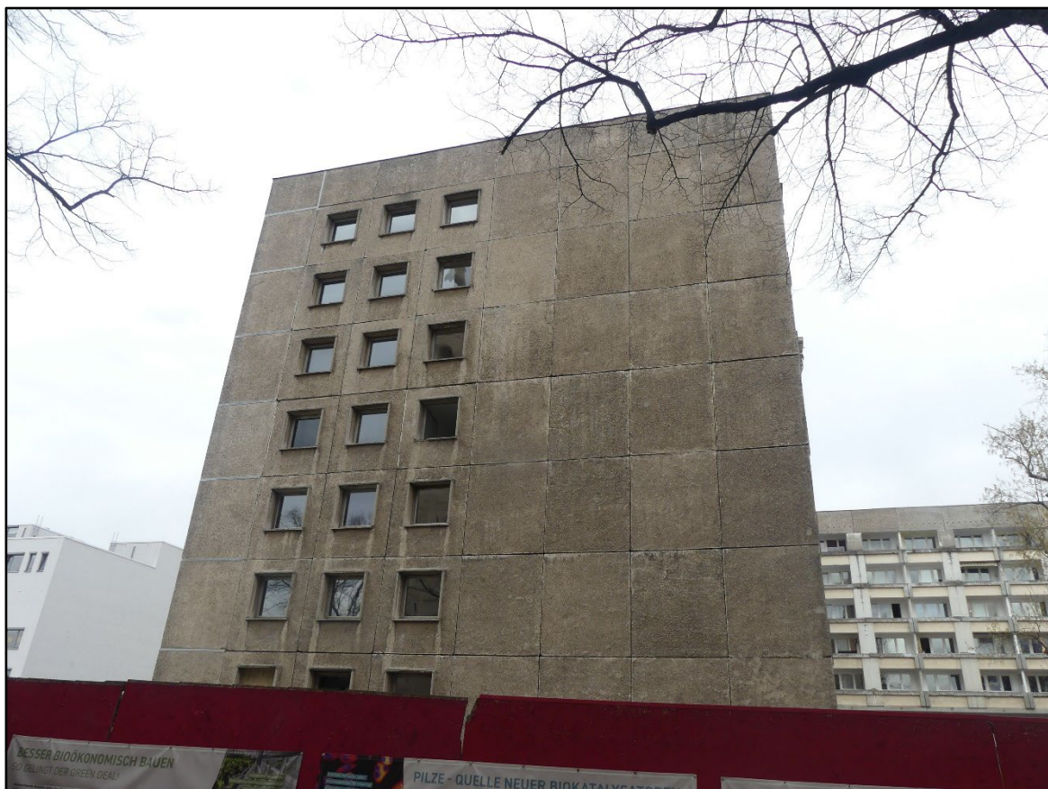
Bild 6 – Südseite des „Staudenhofs“ mit offenen Plattenfugen
