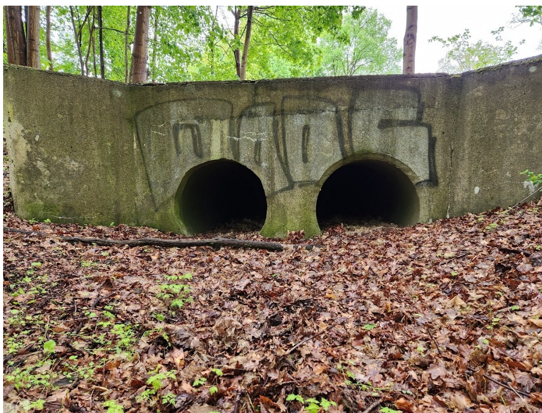
Abbildung 2-4: Durchlassbeginn des Trebuser Grabens oberhalb der Straße der Befreiung (13.05.2026)
