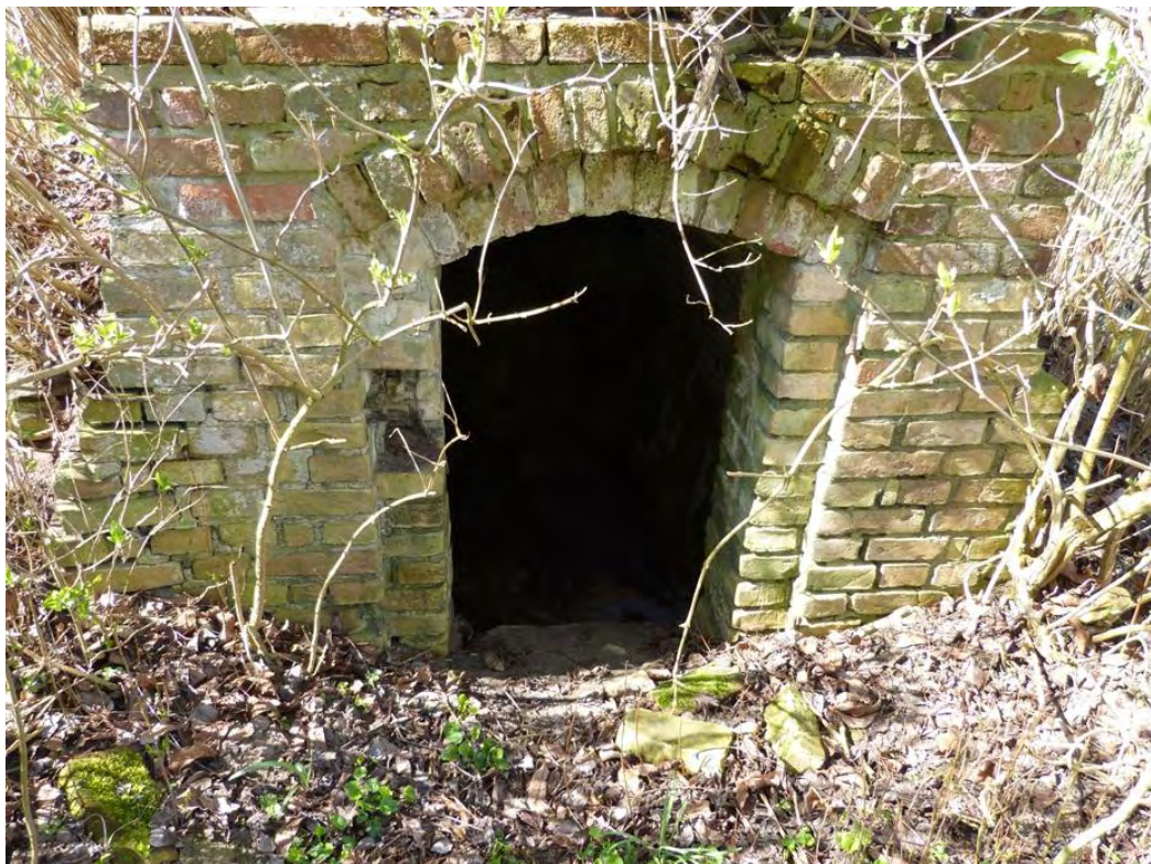
Bild 6: Keller zur Umnutzung als Fledermausquartier im Westteil
