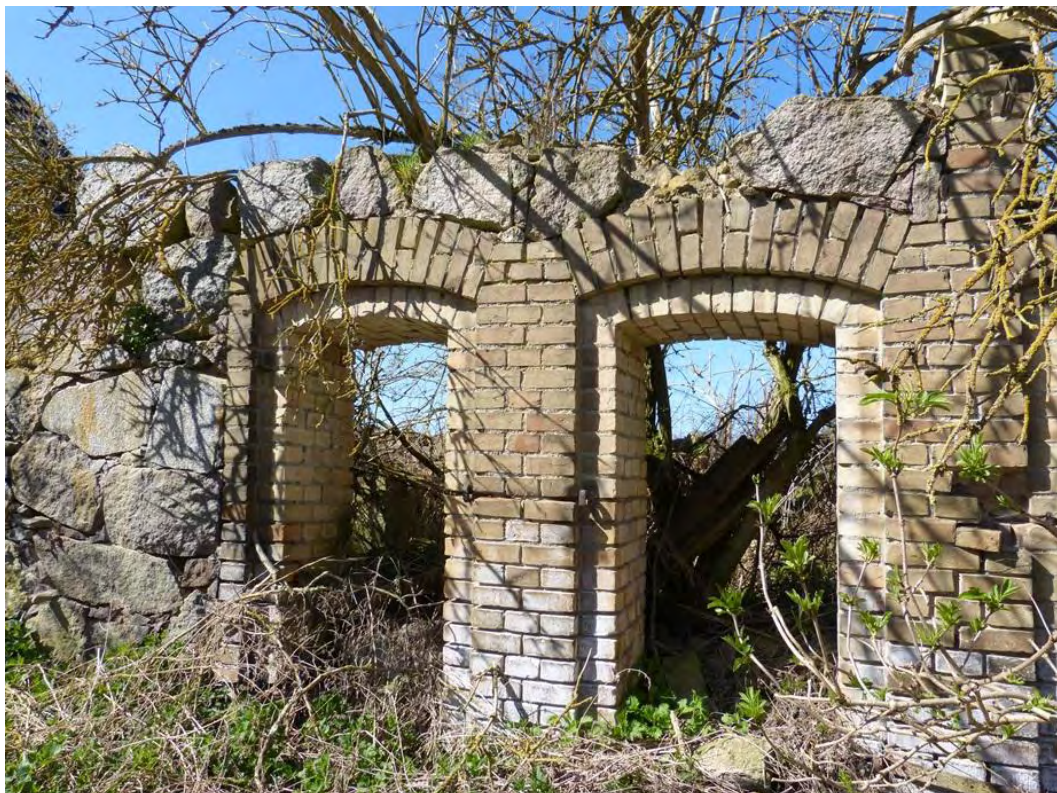
Bild 4: Blick auf Ruinen im Zentrum zwischen Wohnhaus und Stall
