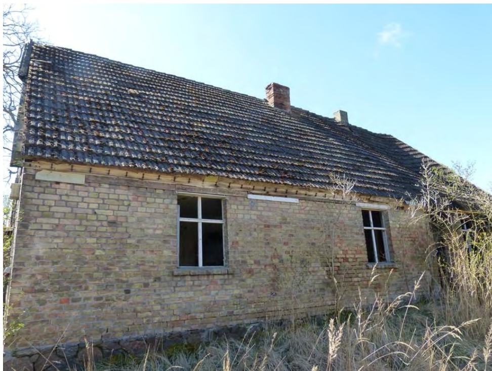
Bild 1: Blick auf desolates Wohnhaus im Zentrum
