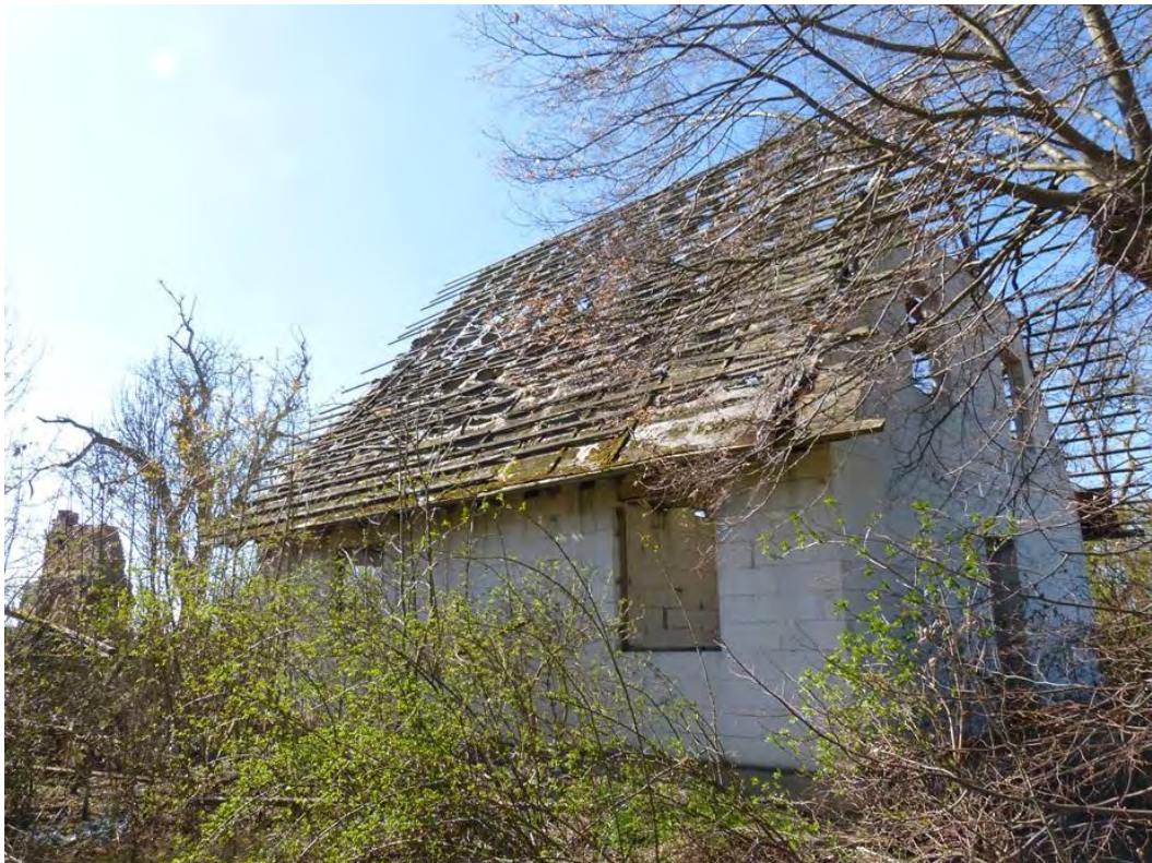
Bild 5: Desolater Rohbau im westlichen Bereich
