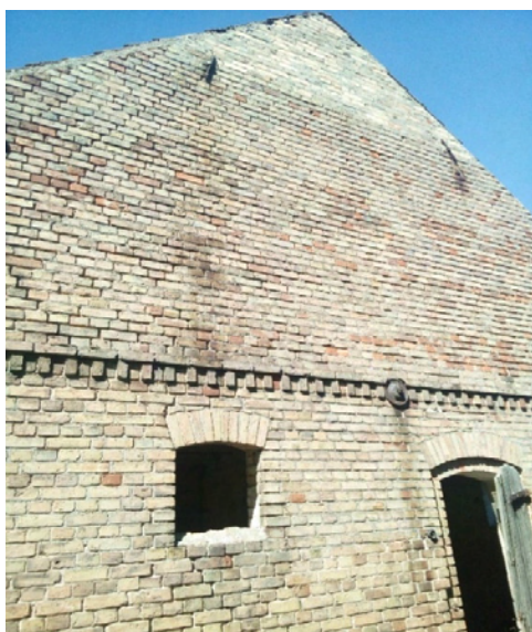
Abb. 13: Im mürben Mörtel der Mauerfugen konnten zahlreiche Brutröhren von Solitärwespen und Wildbienen nachgewiesen werden.
