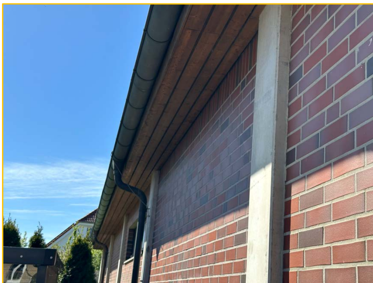
Abb. 9: Karl-Marx-Str. 36 Großziethen: Der Dachkasten ist gut abgedichtet. Einschlupfmöglichkeiten für Fleder- mäuse waren nicht erkennbar. Es waren keine Spuren von Gebäudebrütern zu finden.
