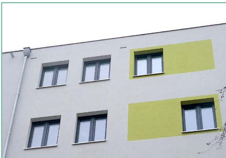
Abb. 22: Integration von Fledermausverstecken (Fledermauseinlaufblende 1FE) in einen Neubau. Eckertstraße 3A, 4A, 5A, Petersburger Straße 72D, 72E in Berlin-Friedrichshain, 2019.
