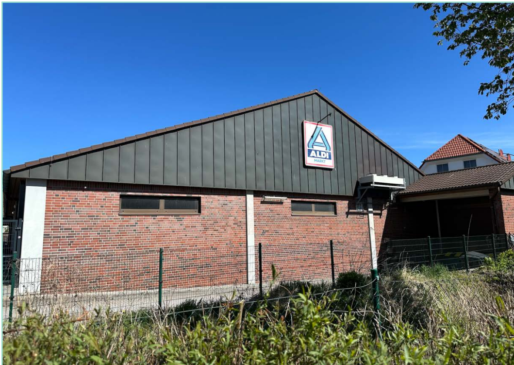
Abb. 5: Untersuchungsgebiet Karl-Marx-Str. 36 in der Gemeinde Schönefeld, OT Großziethen: Schwerpunkt der faunistischen Untersuchung war die Suche nach Verstecken Gebäude bewohnender Fledermäuse und die Suche nach Nistplätzen von Gebäudebrütern.
