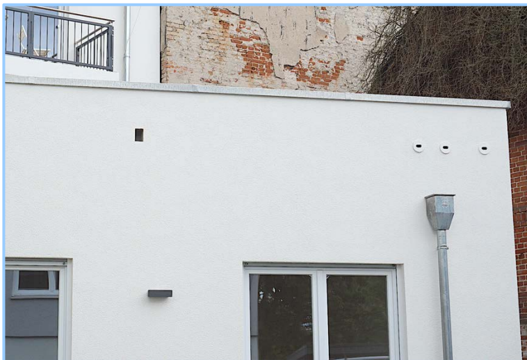
Abb. 21: Integration von einem Mauerseglerkasten 17A, dreifach und einer Halbhöhle 1HE für Hausrotschwänze in einen Neubau. Tino-Schwierzina-Str. 5 in Berlin-Heinersdorf, 2021.
