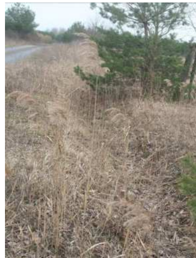
03.03.2024 Graben am „Stradower Weg“ ohne Wasser trotz erheblichen Niederschlägen bis März
