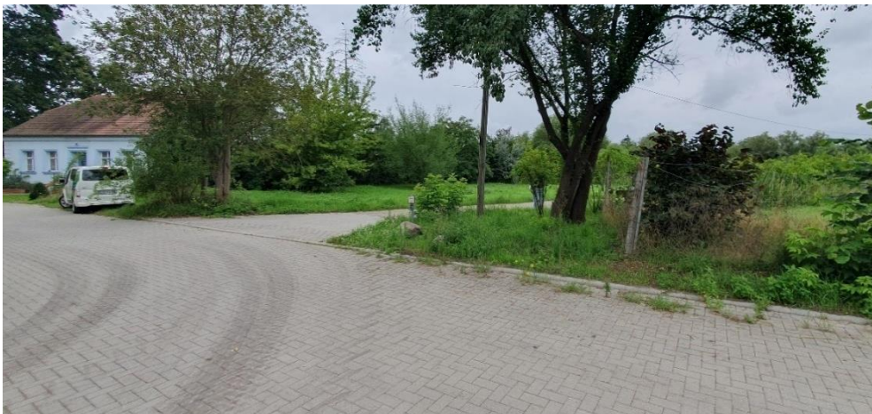
Abbildung 20: Pflasterstraße am südlichen Zipfel des Geltungsbereichs (eigene Aufnahme)
