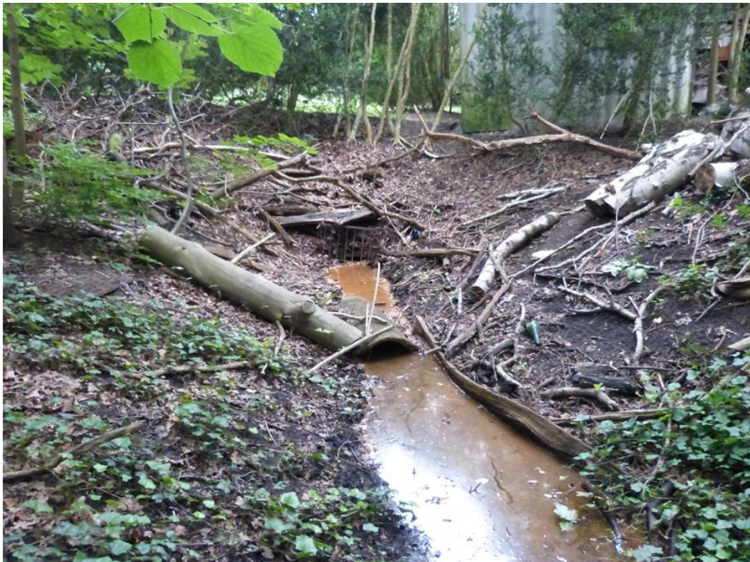
Bild 7: Graben mit Übergang in die Verrohrung an der Westgrenze des Plangebiets
