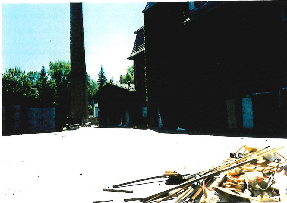
Bild:27/1 im Vorder- und Hintergrund direkt an der Betonmauer Ablagerungen unterschiedlicher Stoffgruppen 200 ° SSW
