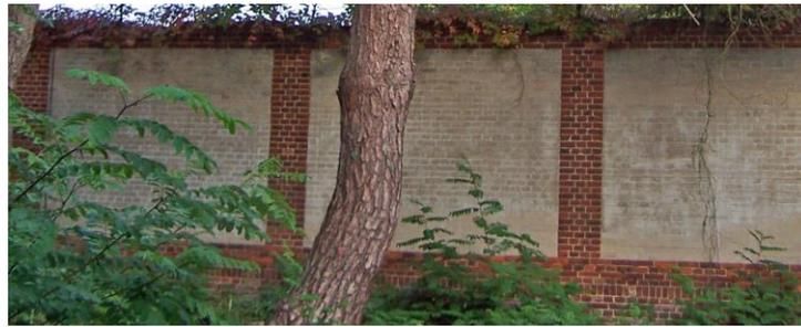
Abb. 22 Aktuelle Situation der Fachungen in der Gefängnismauer
