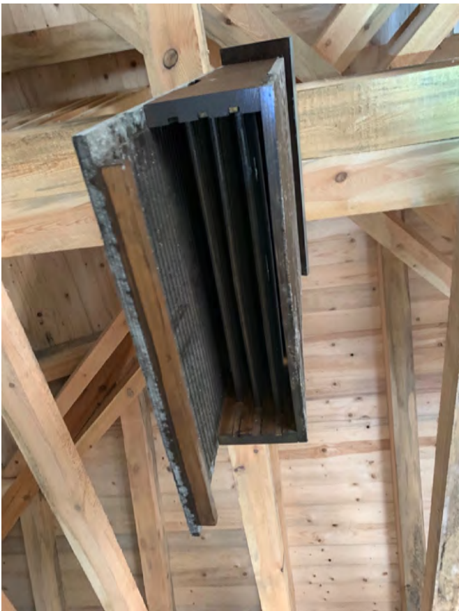
Abbildung 4: Beispiel für geeignetes Spaltenquartier für Dachraum
