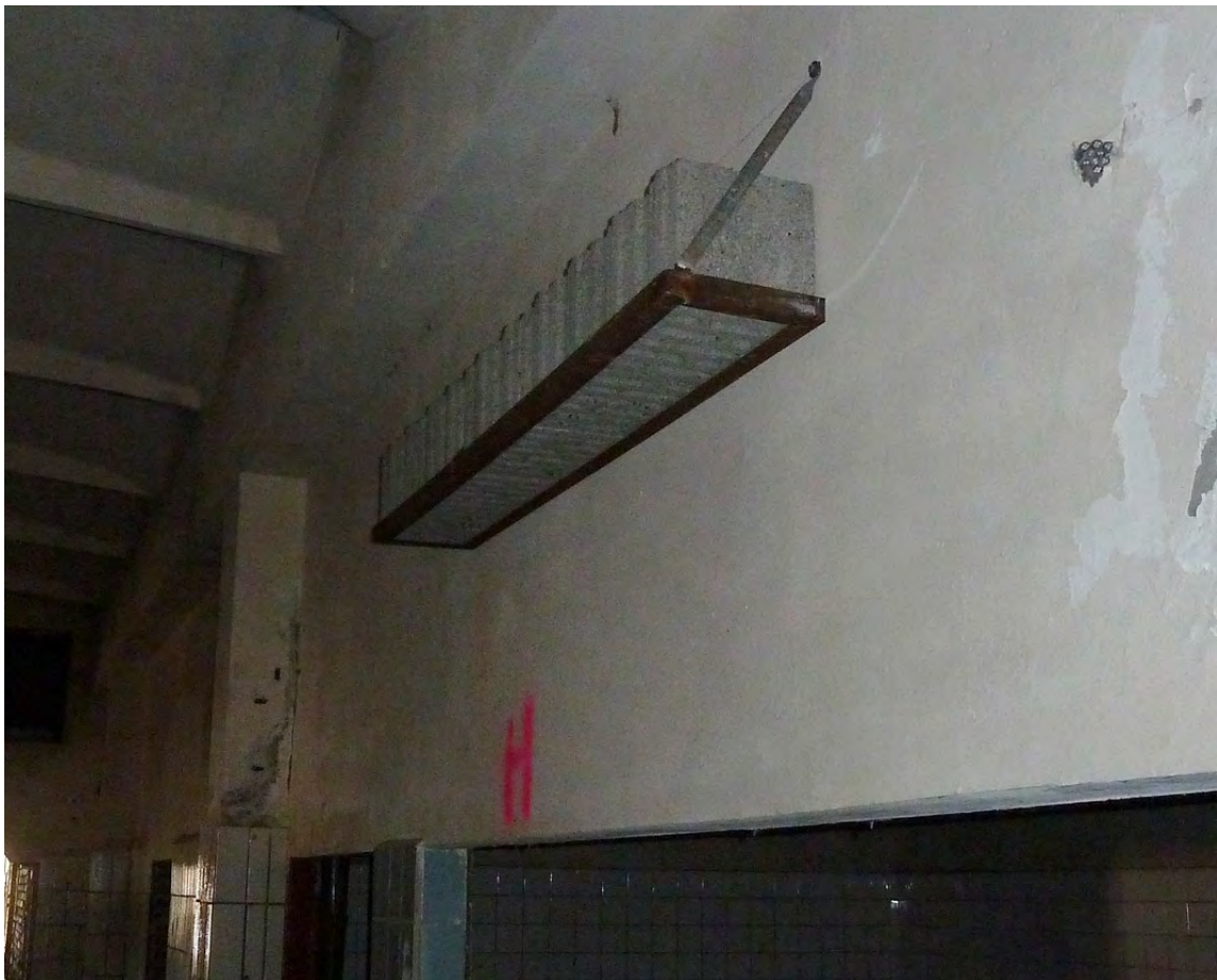
Abbildung 17: Hangplatzoptimierung durch Anbringung s.g. „Winkler-Steine“ an Wänden
