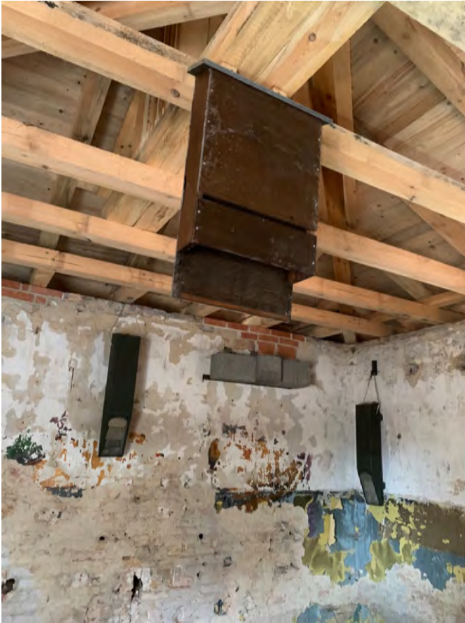
Abbildung 3: Beispiel für geeignetes Spaltenquartier für Dachraum
