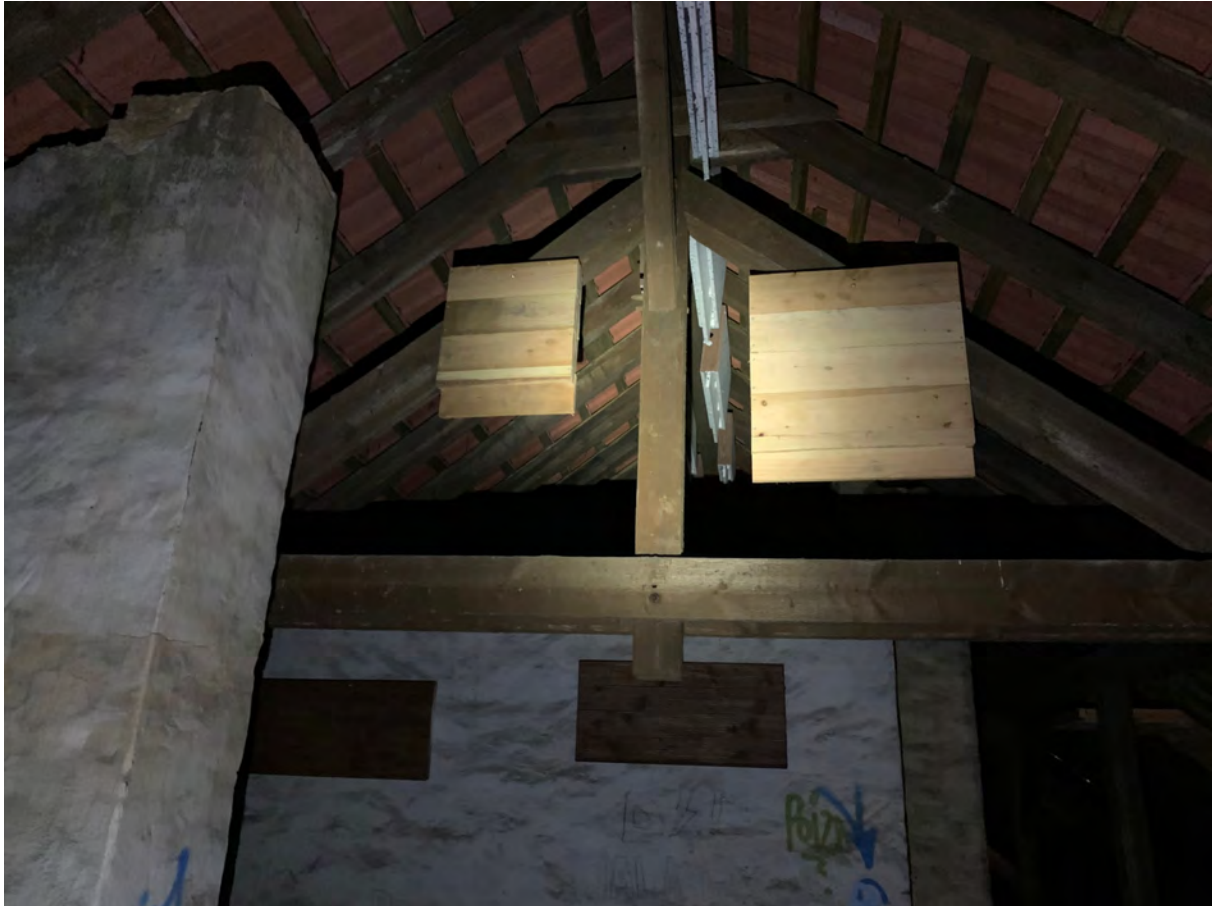
Abbildung 1: Anbringungsbeispiel Fledermauskasten auf Dachboden (kein Einsatz von Kästen aus Styropor), im Hintergrund Spaltenquartiere an Wand oder Schornsteinen
