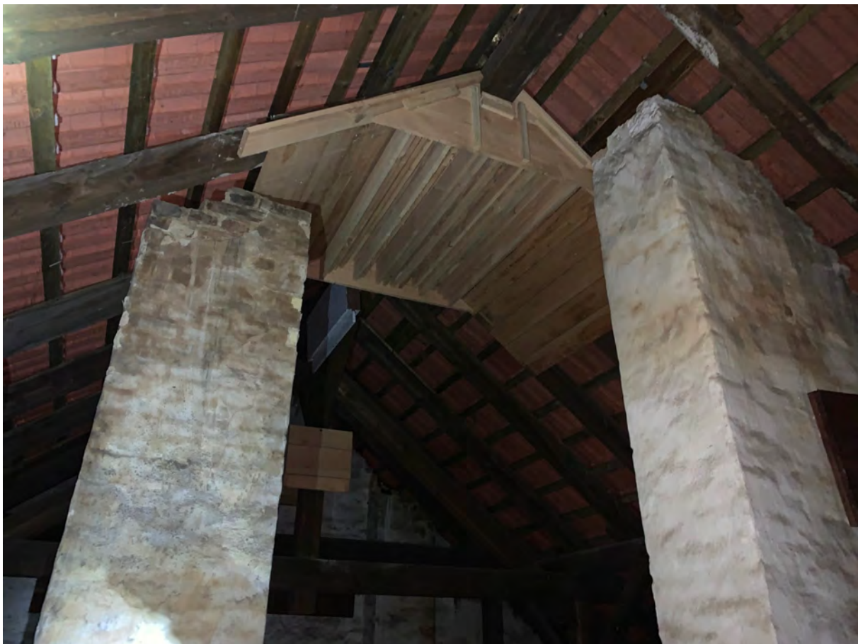
Abbildung 6: Einbaubeispiel einer Wärmeglocke mit unterschiedlich breiten Spaltenquartieren
