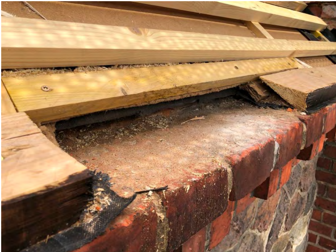
Abbildung 9: Einflugmöglichkeit zwischen Fassade und erster Ziegellage
