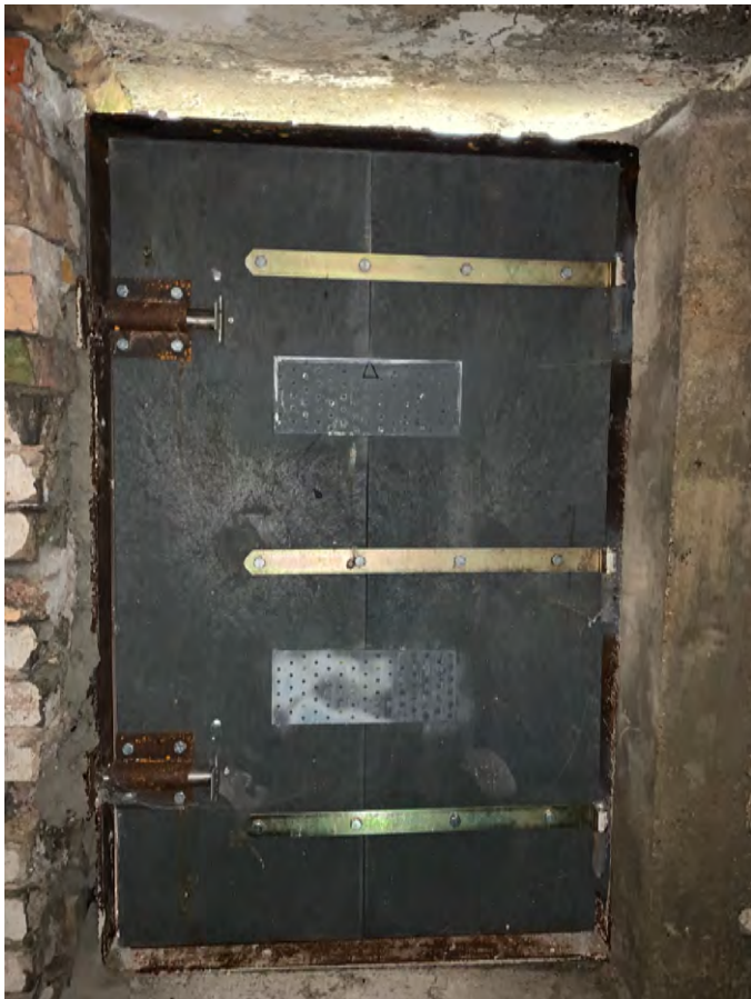
Abbildung 22: Beispiel Verschluss der Eingangsbereiche durch massive Tür mit Einflugmöglichkeit für Fledermäuse
