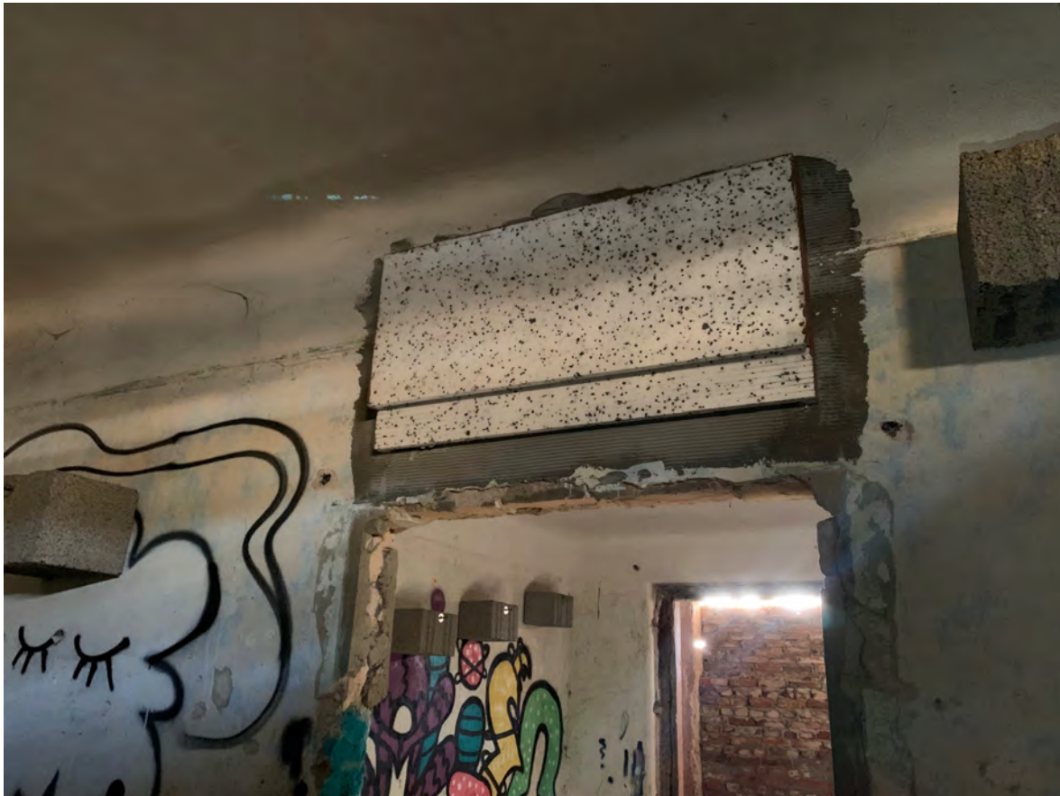
Abbildung 18: Hangplatzoptimierung durch Anbringung s.g. „Winkler-Steine“ an Wänden und Anbringung von Spaltenquartieren (allerdings nicht mittels Styropor, wie in diesem Beispiel dargestellt)
