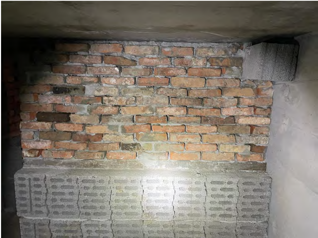
Abbildung 20: Hangplatzoptimierung Errichtung von lückigen Mauern aus alten Ziegeln
