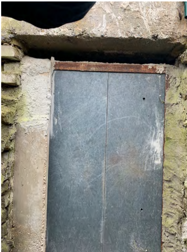
Abbildung 21: Beispiel Verschluss der Eingangsbereiche durch massive Tür mit Einflugmöglichkeit für Fledermäuse
