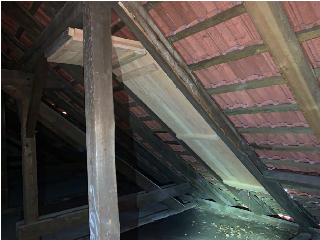
Abbildung 7: Beispiel für Quartiersersatz zwischen Dachsparren (2 pro Dachraum in unterschiedlichen Himmelsrichtungen erforderlich. Dieser Typ kann auch zwischen Unterspannbahn und Dachziegeln eingesetzt werden.
