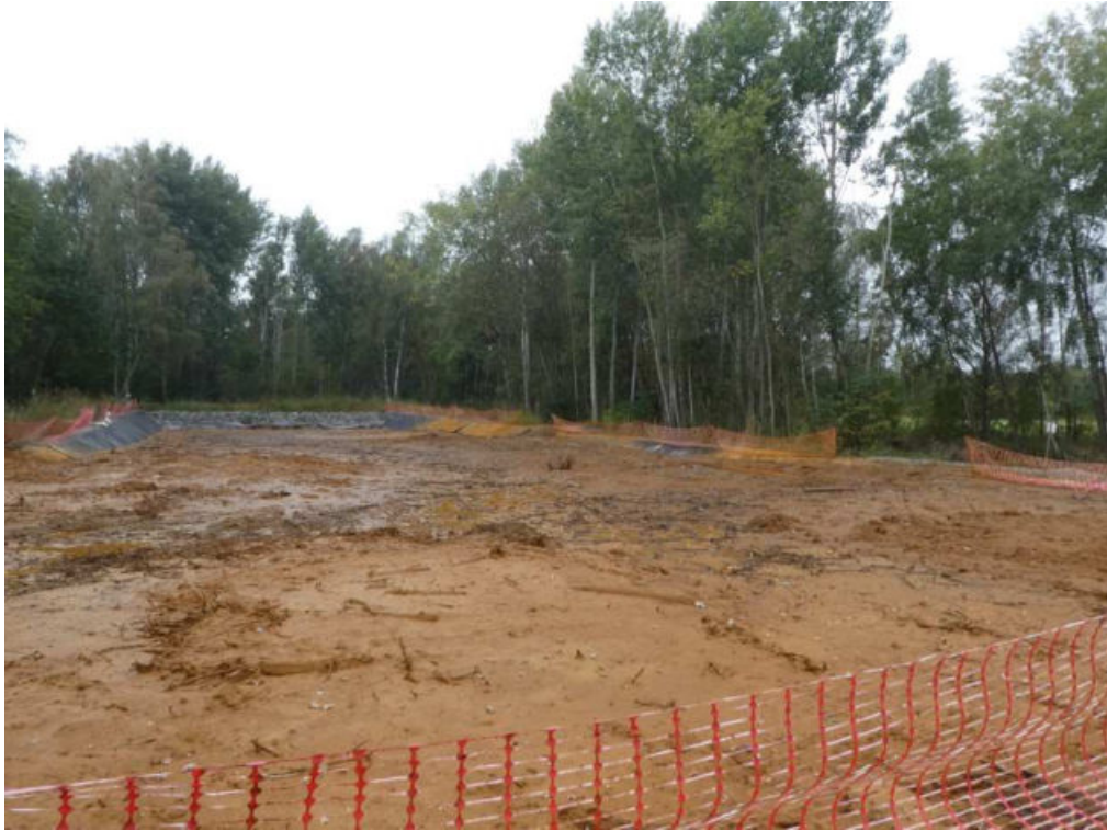
Foto 2. Absetzbecken für Eisenhydroxidschlamm aus der Pößnitz am Ostufer oberhalb vom „Sonnenhäuschen“.- Foto: R. Möckel (11.10.2021)
