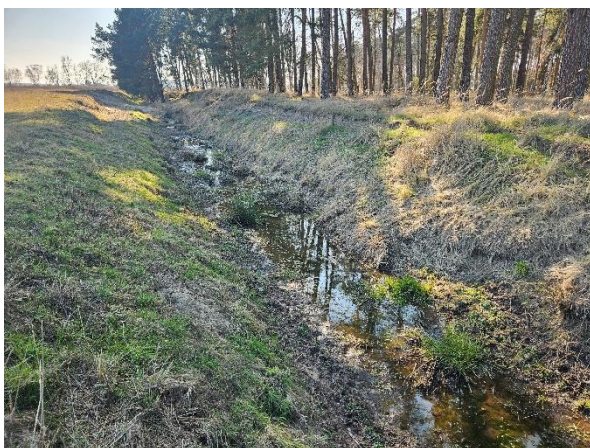
Abbildung 12: Östlicher Graben mit geringer Wasserführung am 06.03.2025
