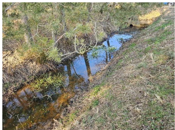
Abbildung 13: Östlicher Graben mit Wasserführung am 06.03.2025
