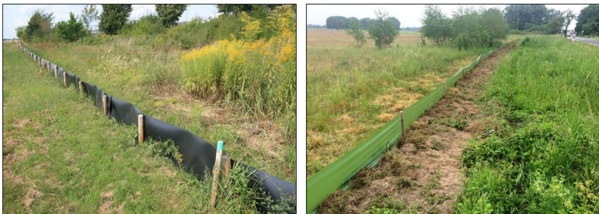
Abbildung 4: Beispiele für die Gestaltung eines Reptilienschutzzaunes. Aufnahmen Hagen Roßmann
