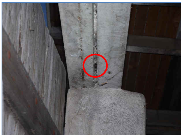
Abb. 4 Besiedeltes Spaltenquartier zwischen zwei Betonstützen.
