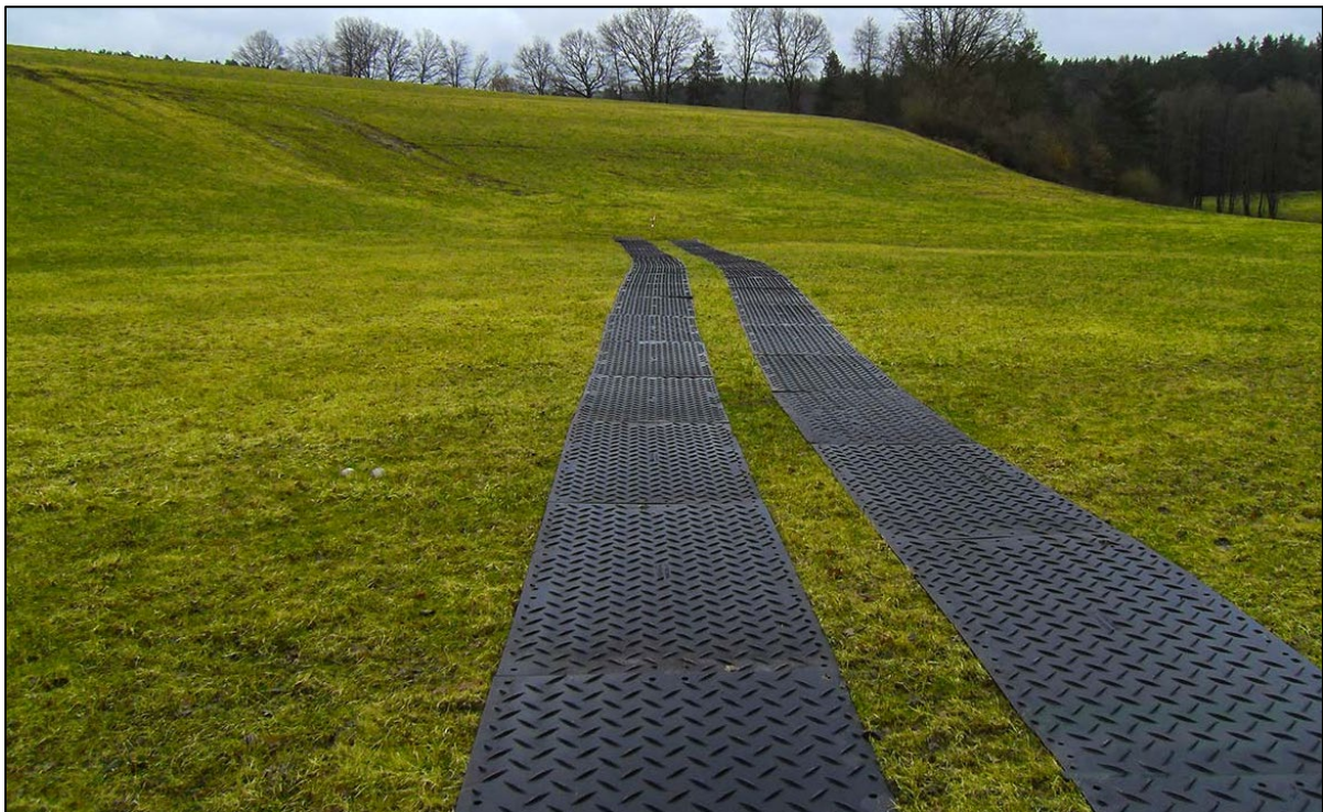
Abbildung 8: Beispielfoto mobile Baustraße zur Vermeidung von Bodenverdichtung ( https://www.securatek.de/Referenzen/s-tek-48-Hochleistungs-Bodenschutzplatte-als-Mobile-Baustrasse-beim-Rohrleitungsbau-bei-Creussen-in-Bayern )
