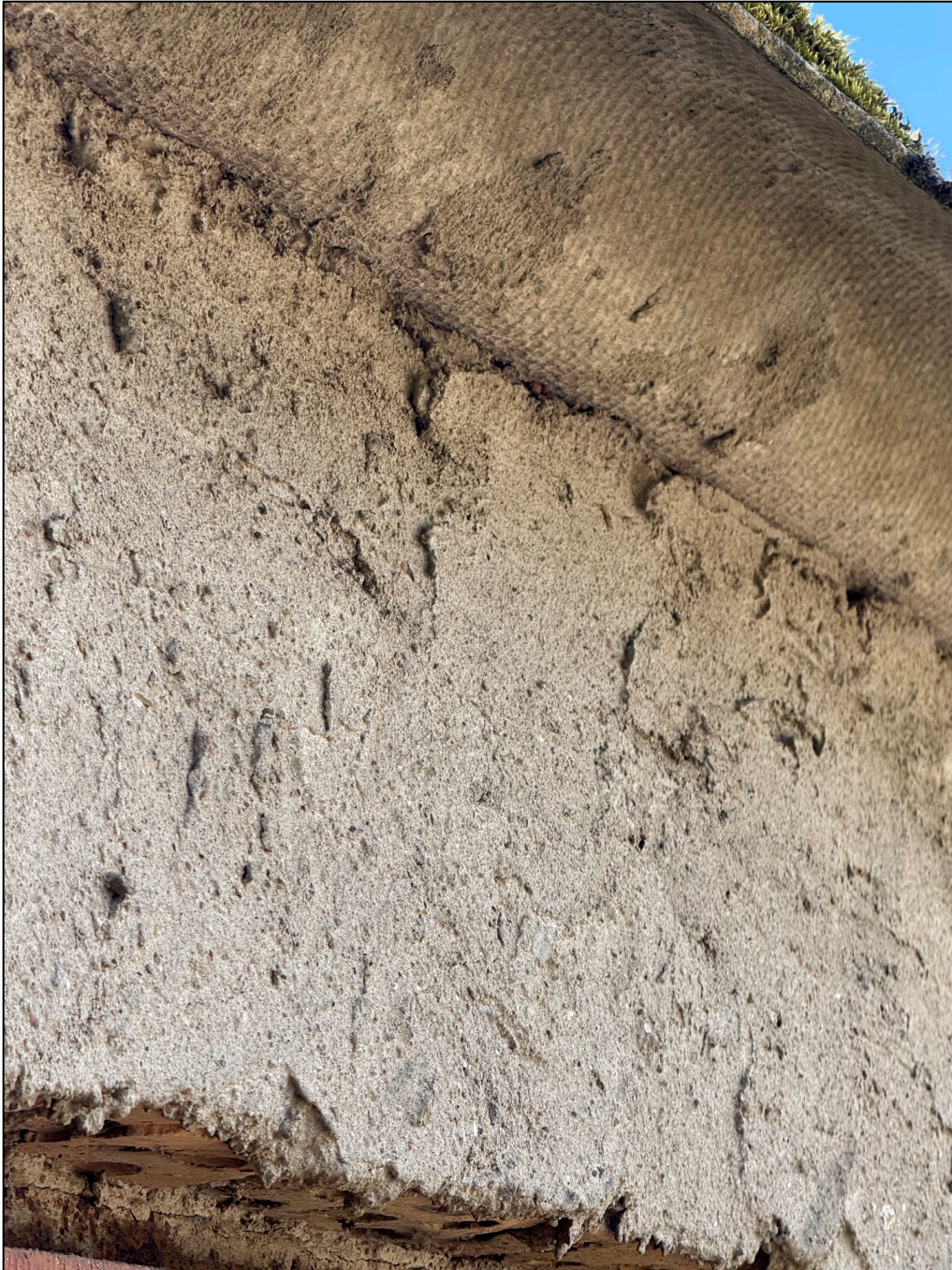
Abbildung 7: Weitere Innenaufnahme des Deckenbereichs. Auch hier nur Spinnweben, keine Hinweise auf frische Nutzung durch Fledermäuse.
