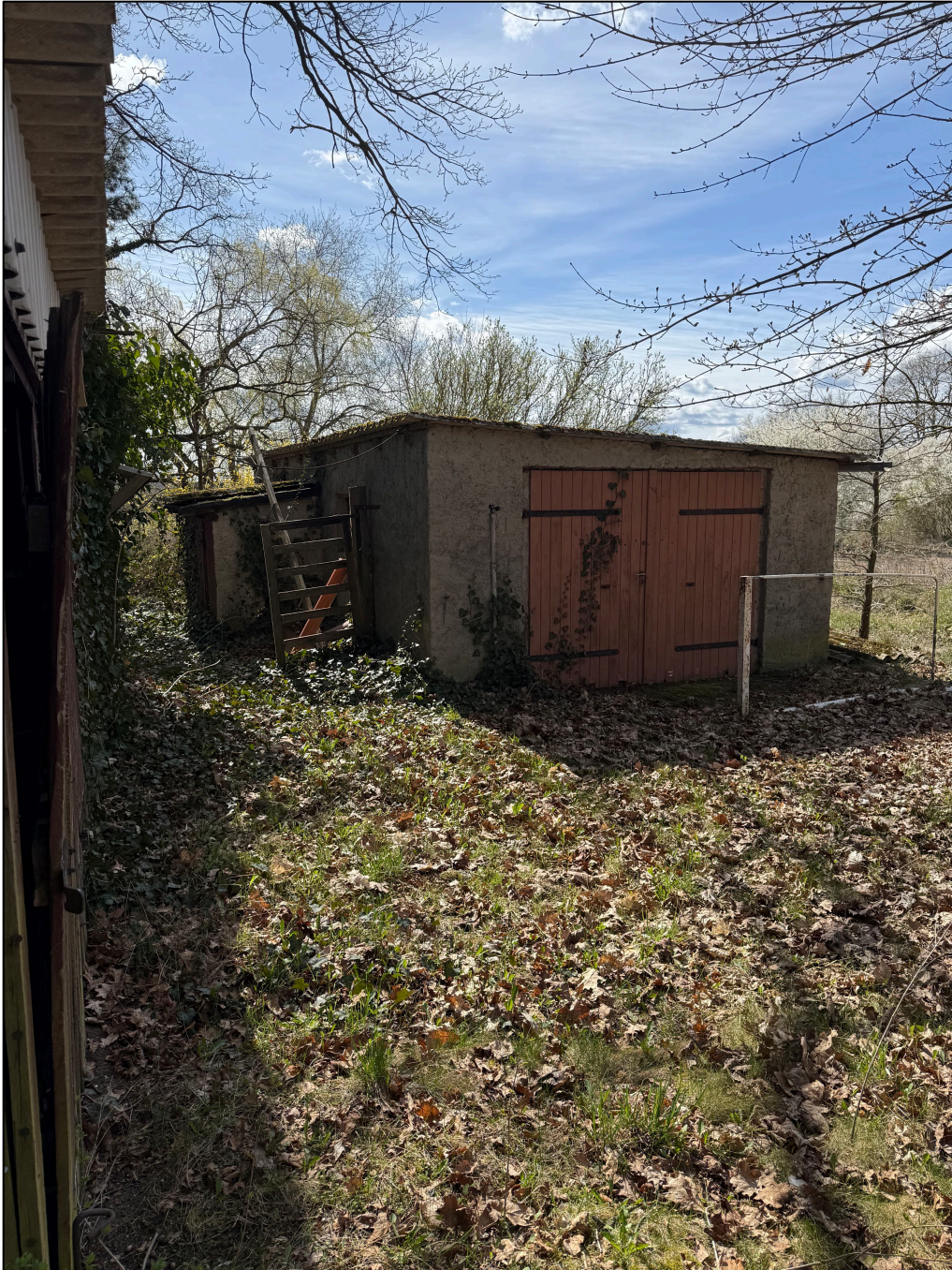
Abbildung 4: Südliche Außenwand eines weiteren Nebengebäudes mit Eingangstür. Auch hier keine Hinweise auf regelmäßige Nutzung der Spalten und Öffnungen durch Fledermäuse.
