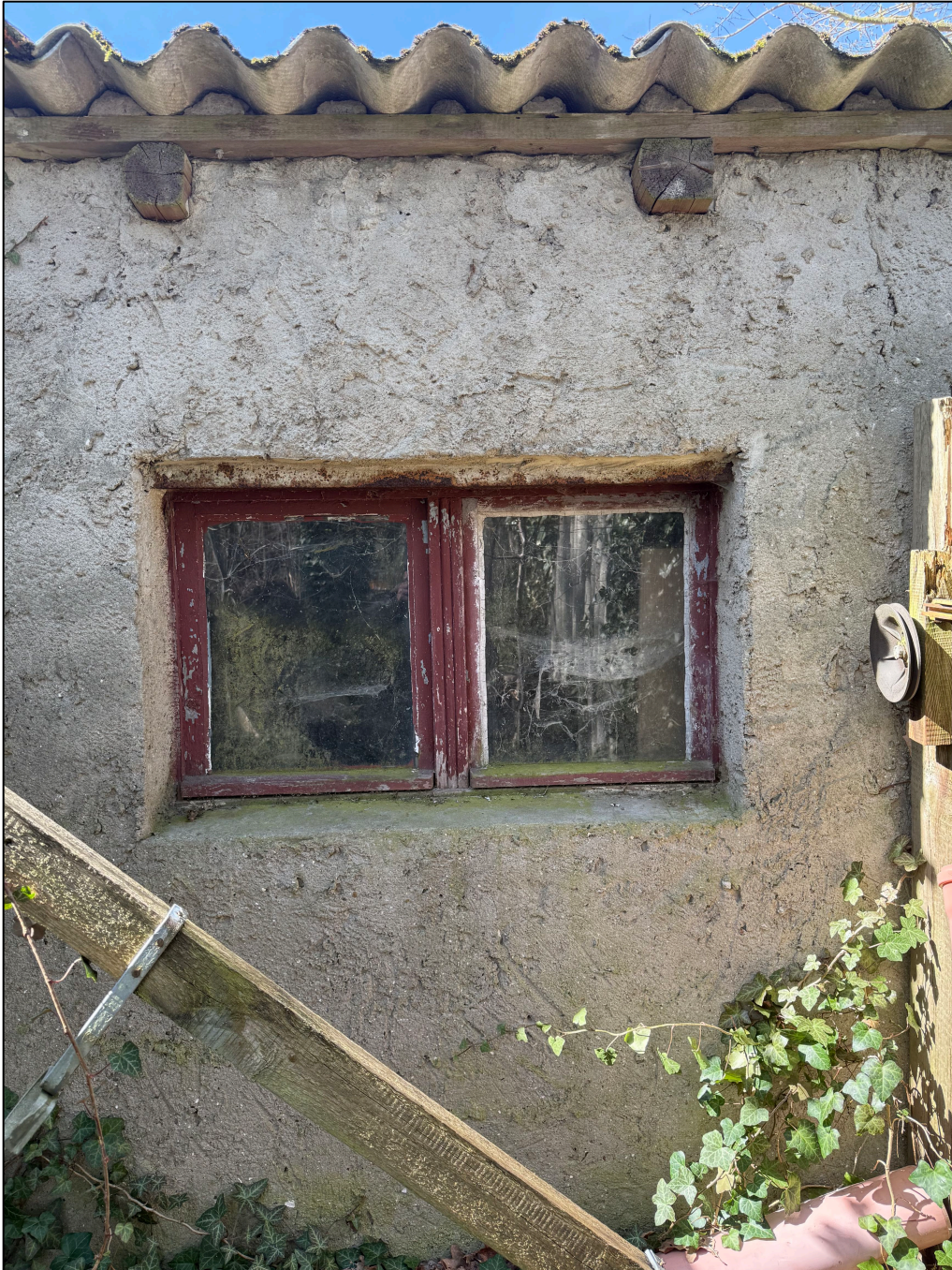
Abbildung 3: Detailaufnahme des gleichen Fensters, Spinnweben durchgängig – kein Hinweis auf Durchflug, Nutzung ausgeschlossen.
