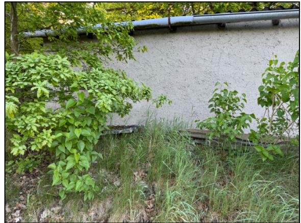
Abbildung 6: Östlich des PG gelagerte Wellplatten.
