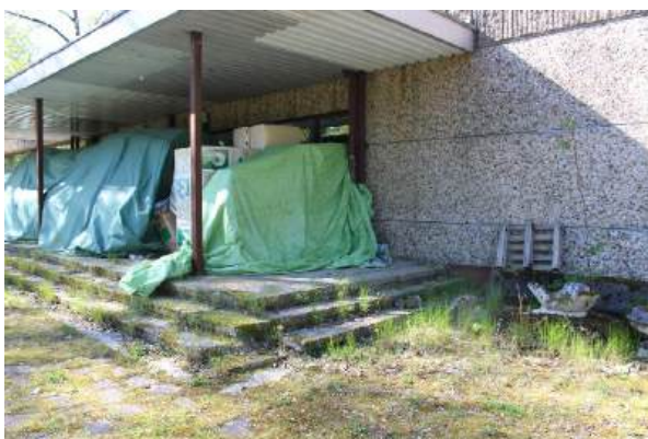
Abbildung 13: Kantine Nutzung als u.a. Heulager
