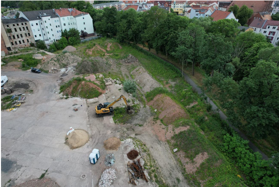
Drohnenaufnahme – südlicher Geltungsbereich im Detail (Quelle: BAGU, 06.06.24)
