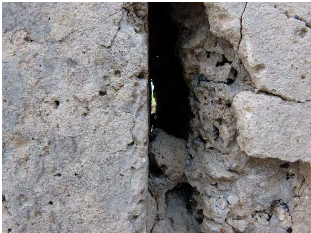
Bild 8: Untersuchung Hohlräume im Mauerwerk des ehemaligen Stallgebäudes
