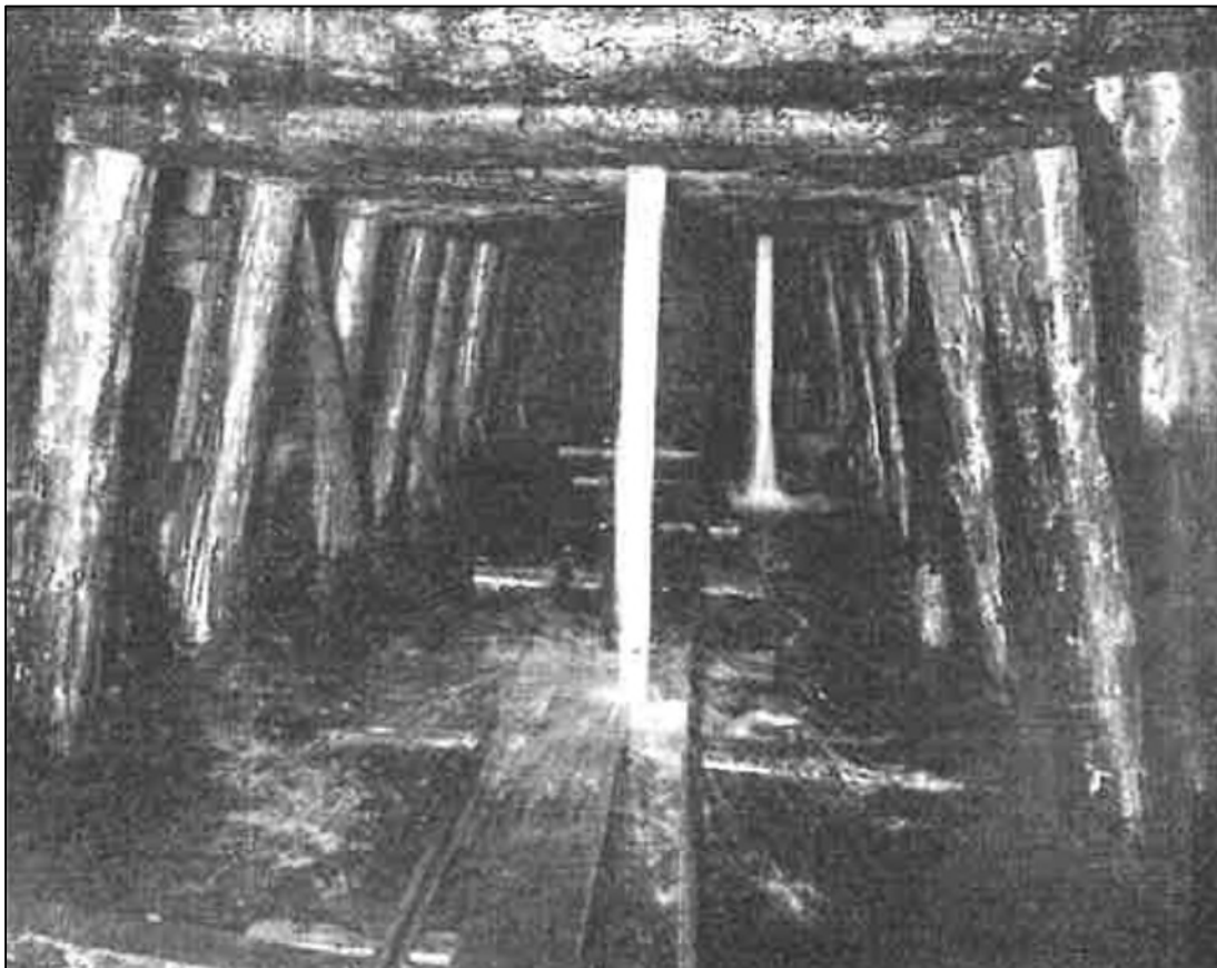
Abbildung 6: Entwässerungsstrecke mit entwässernden Fallfiltern in der Grube „Clara“ in Welzow
