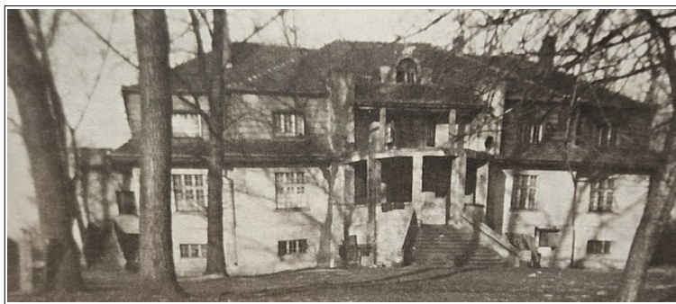
Abb. 4: Ehemaliges Gut auf dem Flurstück 845, Gebäude heute nicht mehr vorhanden
