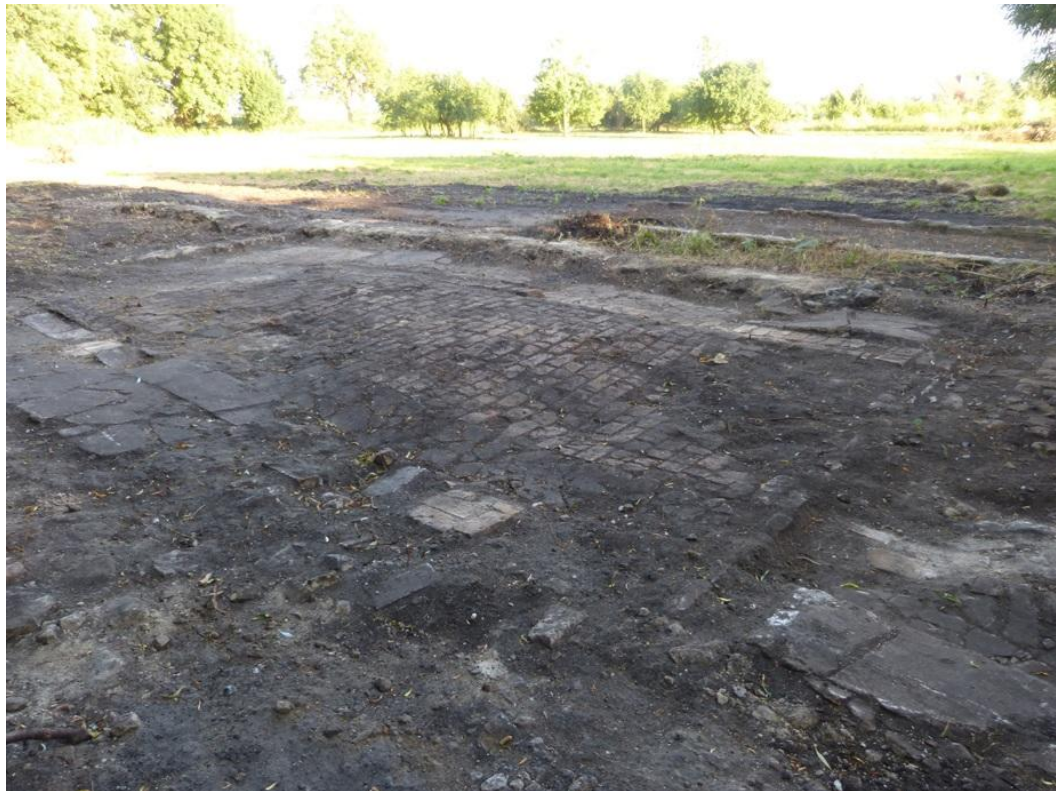
Bild 7: Flächenbefestigung nordöstlich des großen Stallgebäudes
