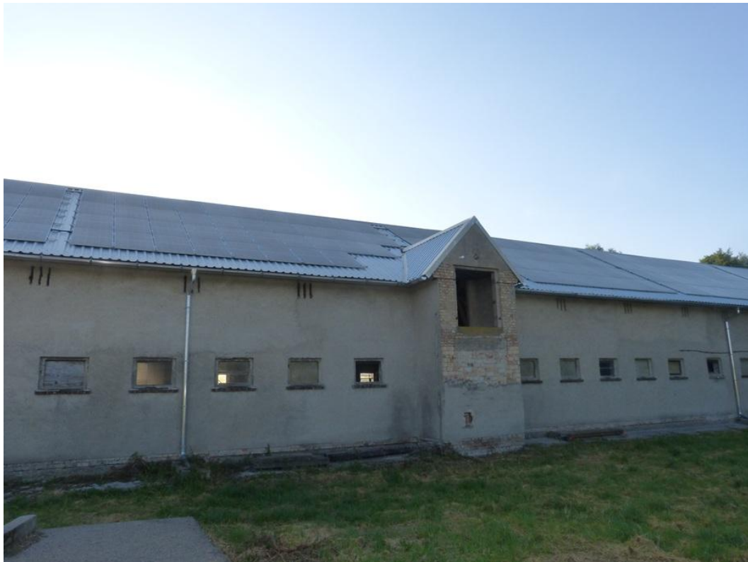
Bild 3: Großes Stallgebäude im Zentrum des geplanten Biohofs (geplantes Besucherzentrum)
