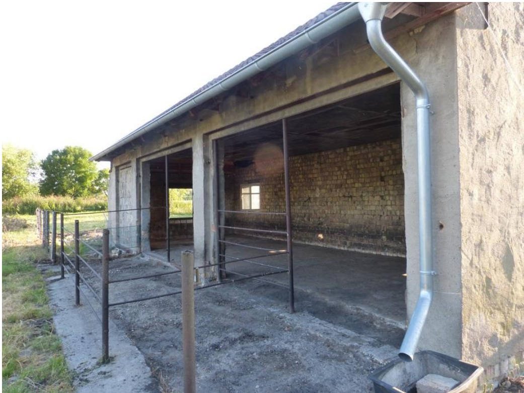
Bild 11: Kleines Stallgebäude im Westen (geplante Sternenlounge)
