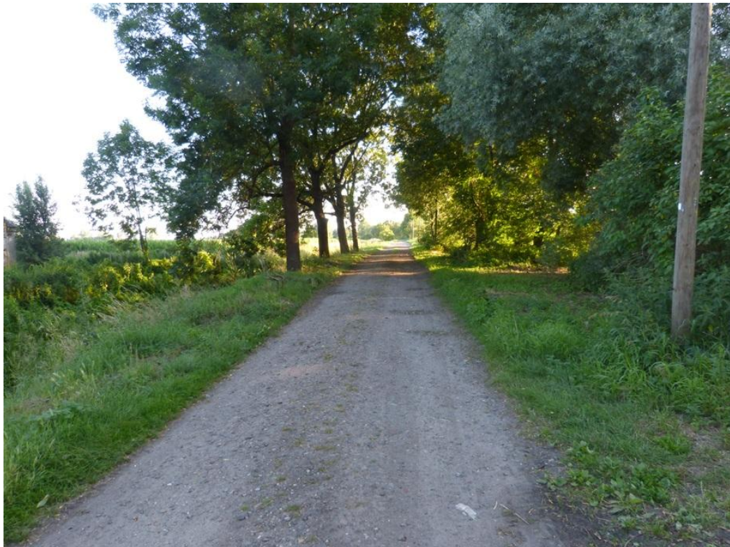
Bild 18: Mit Schotter und Bauschutt befestigter Weg im Ostteil des Plangebiets
