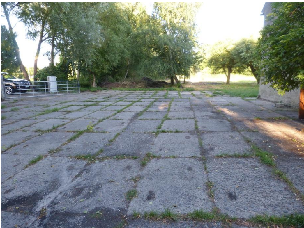
Bild 8: Flächenbefestigung nördlich des großen Stallgebäudes
