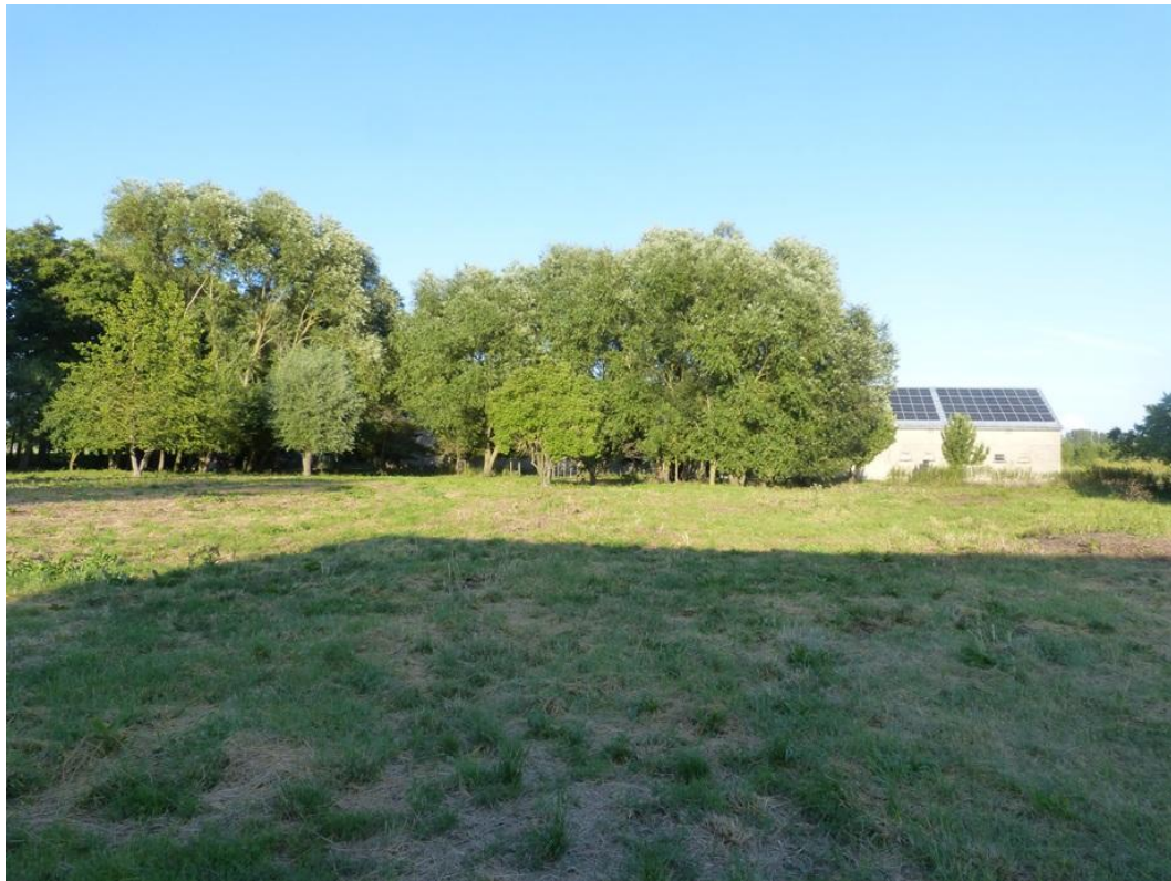
Bild 13: Blick vom kleinen zum großen Stallgebäude
