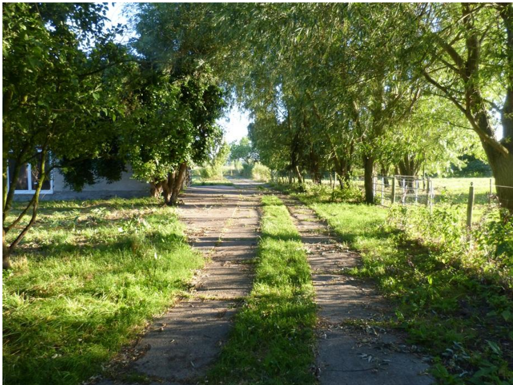
Bild 10: Betonspurbahnweg westlich Flächenbefestigung des großen Stallgebäudes
