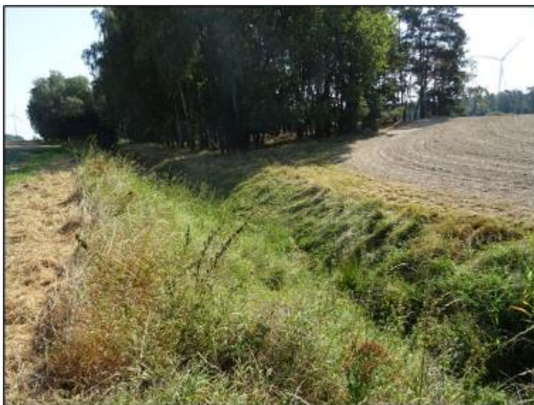
Abbildung 6: Trockengefallener Feldgraben mit Regelprofil, besonnener Abschnitt
