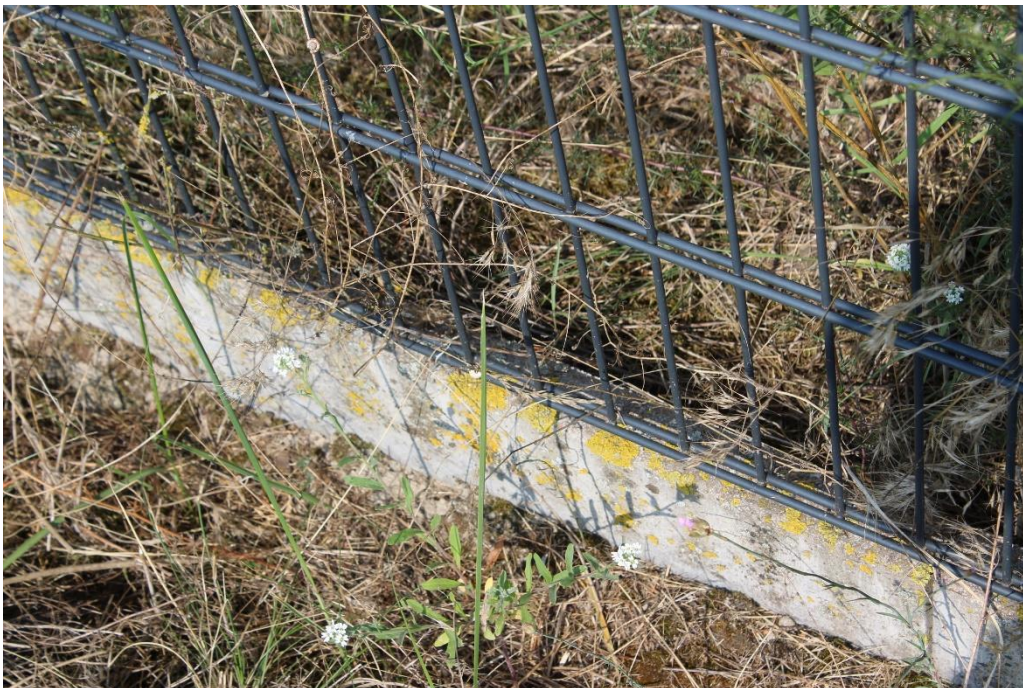
Abbildung 7: Zaunborde, die ein Übersteigen erschwert
