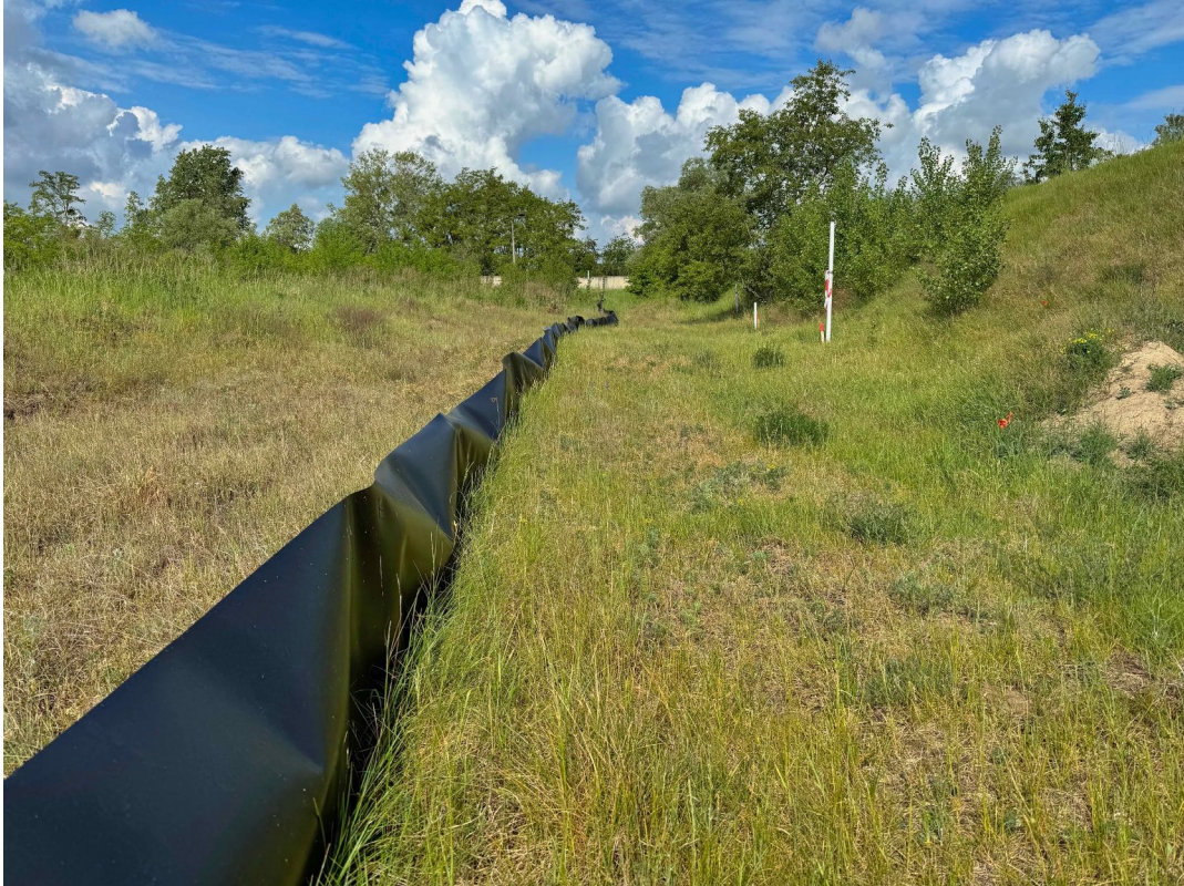
Bild 2: Blick in nordwestliche Richtung
