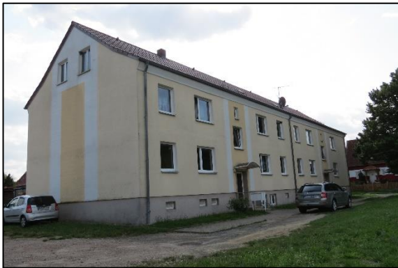
Wohnblock, teilweise im Geltungsbereich, nicht von Abbruch betroffen
