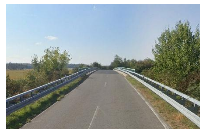
Abbildung 24: Überführung L526 Klein Beuchow
