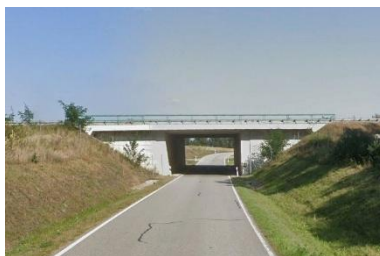
Abbildung 22: Unterführung K6631 Klein Raddener Straße
