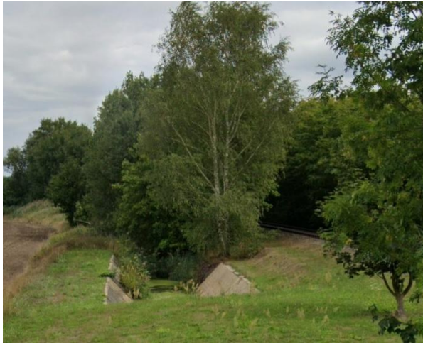
Abbildung 19: Krimnitzer Feldgraben (gegenüber Zufahrt zum Umspannwerk Ragow)
