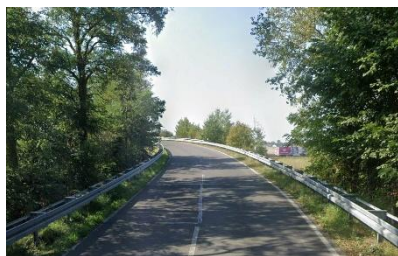
Abbildung 23: Überführung Lübbener Straße
