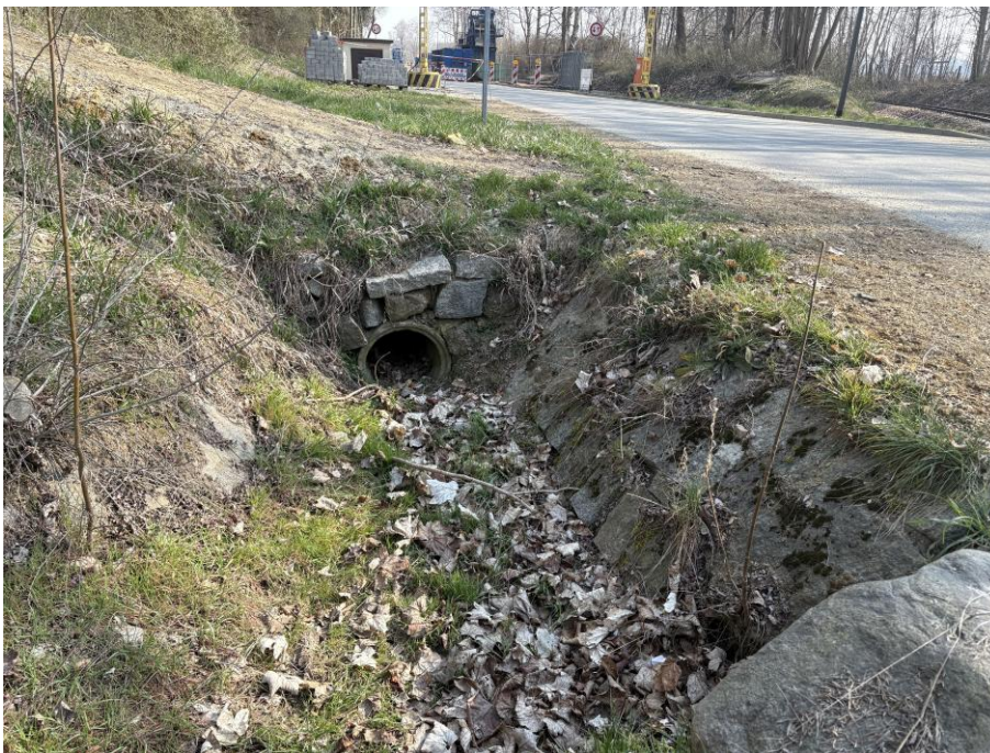
Abbildung 9: Ausläufer des Krimitzer Feldgrabens östlich am Umspannwerk, nicht wasserführend, Foto vom 25.03.2025
