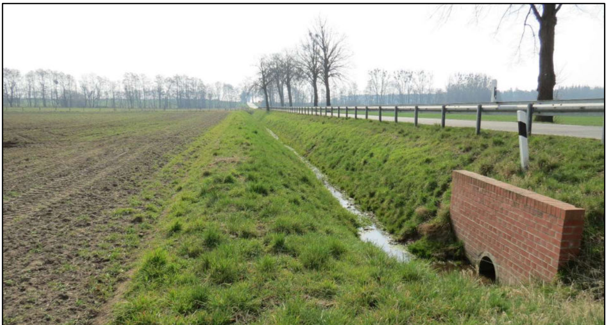
Abbildung 7: von der Quillow abzweigender Grabenverlauf (Nr. 43.2) westlich entlang des Geltungsbereichs, Blickrichtung Nord nach Süd
