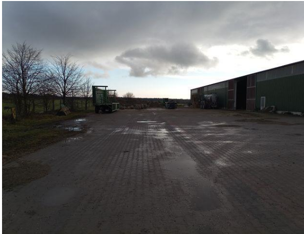
Abb. 28: Blick auf Gewerbefläche im SW (01.12.25)
