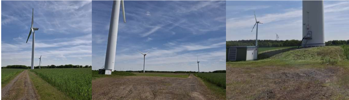
Abbildung 14: Zufahrt (teilversiegelte Wege; linkes Bild), Kranstellfläche, Turm, Fundament und Trafo verschiedener Bestandsanlagen (WEA; mittleres und rechtes Bild).
