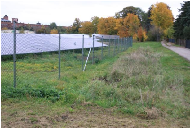
Abb. 5: Solarfeld nördlich Grüner Weg (Foto im Rahmen Geländebegehung EAPlan „Grüner Weg“, GUP 2023)
