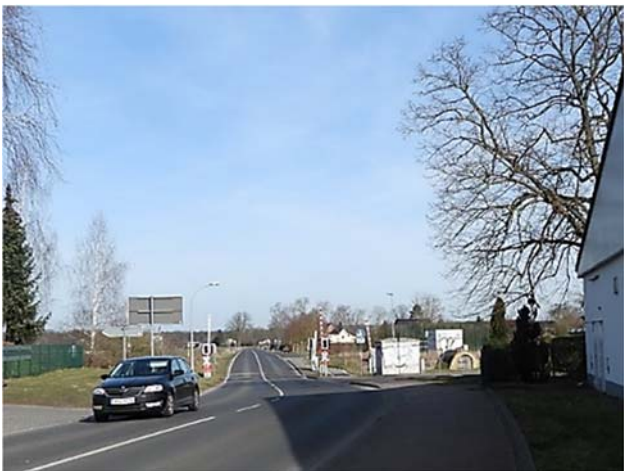
Blick nach Ost entlang der die Bahnhofstraße zum ebenerdigen beschränkten Bahnübergang der Regionalbahnlinie Berlin Schönholz- Kremmen.
