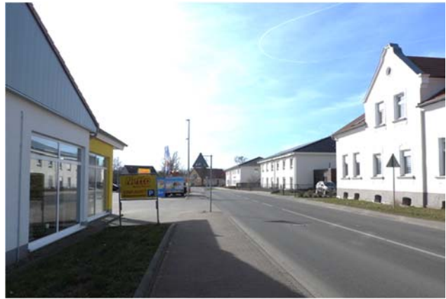
Gehweg an der Bahnhofstraße, der teilweise auf dem Grundstück des Netto-Marktes liegt, Blick von Ost
