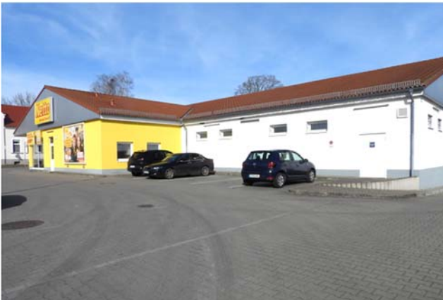
Blick von Südwest zum Gebäude des Netto-Marktes; an dieser Gebäudeseite soll die Erweiterung des Netto-Marktes erfolgen
