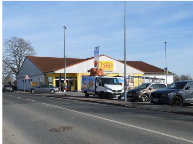
Blick von West in die Bahnhofstraße zum Netto-Verbrauchermarkt
