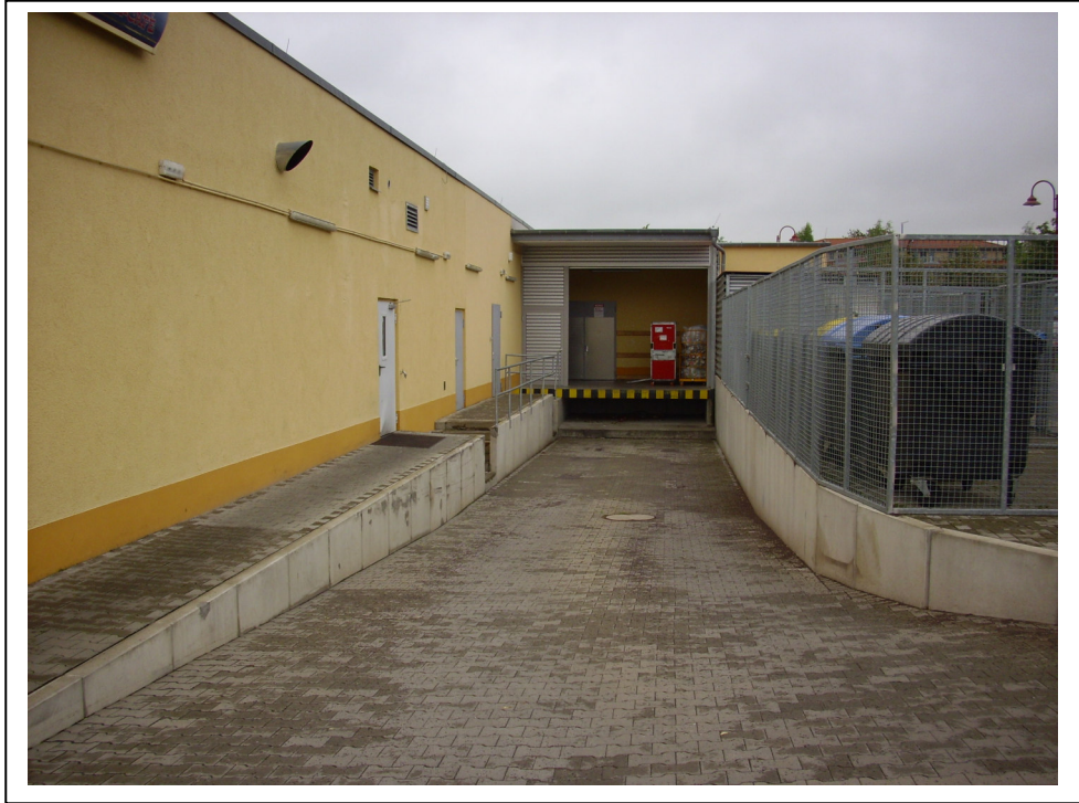
Foto 5: Blick auf die Warenanlieferung des REWE mit einer Betonsteinversiegelung.
