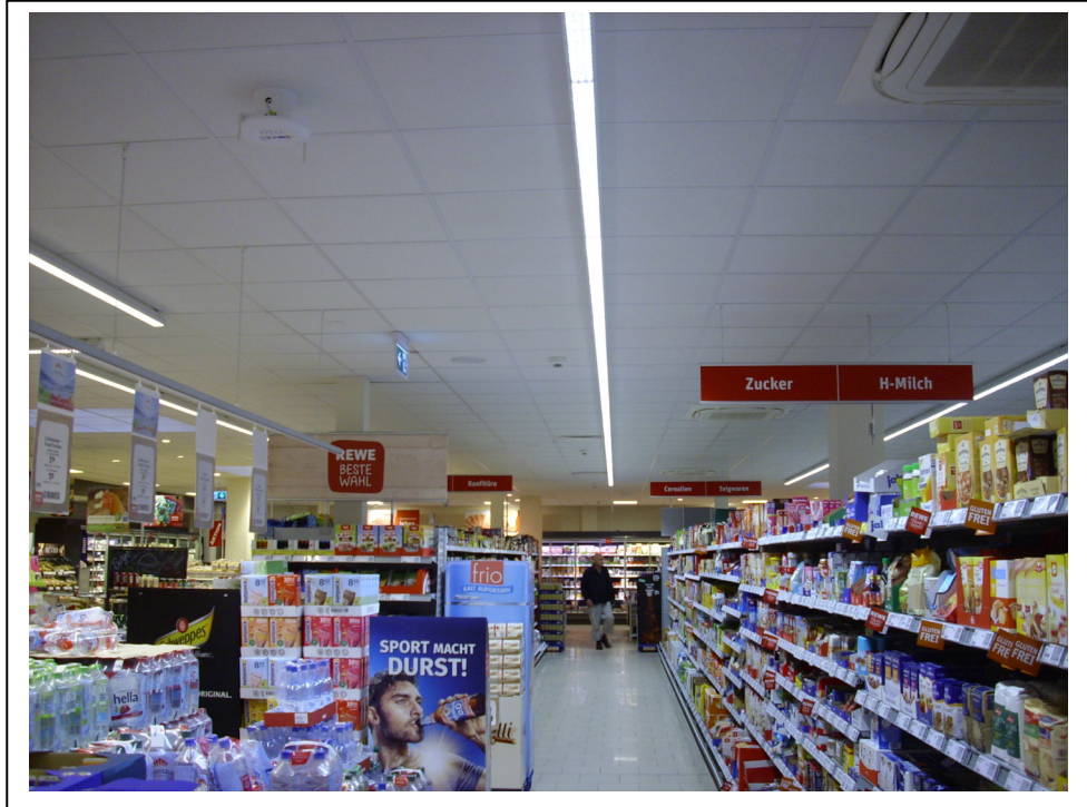
Foto 19: Blick auf die abgehängte Akustikdecke im REWE-Markt – aus 2014.
