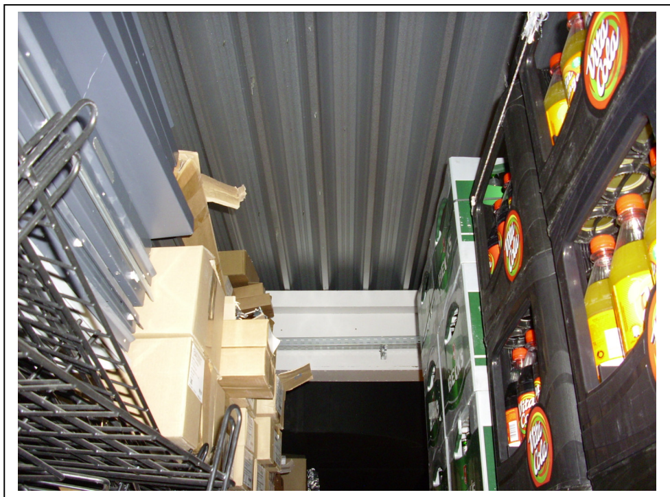
Foto 12: Blick in die Deckenkonstruktion des REWE-Marktes als Stahlbinderkonstruktion.
