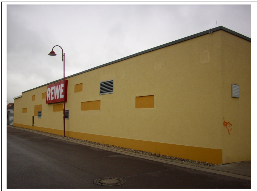
Foto 4: Blick auf die Seitenfront des REWE-Marktes mit dem Wärmedämmverbundsystem.
