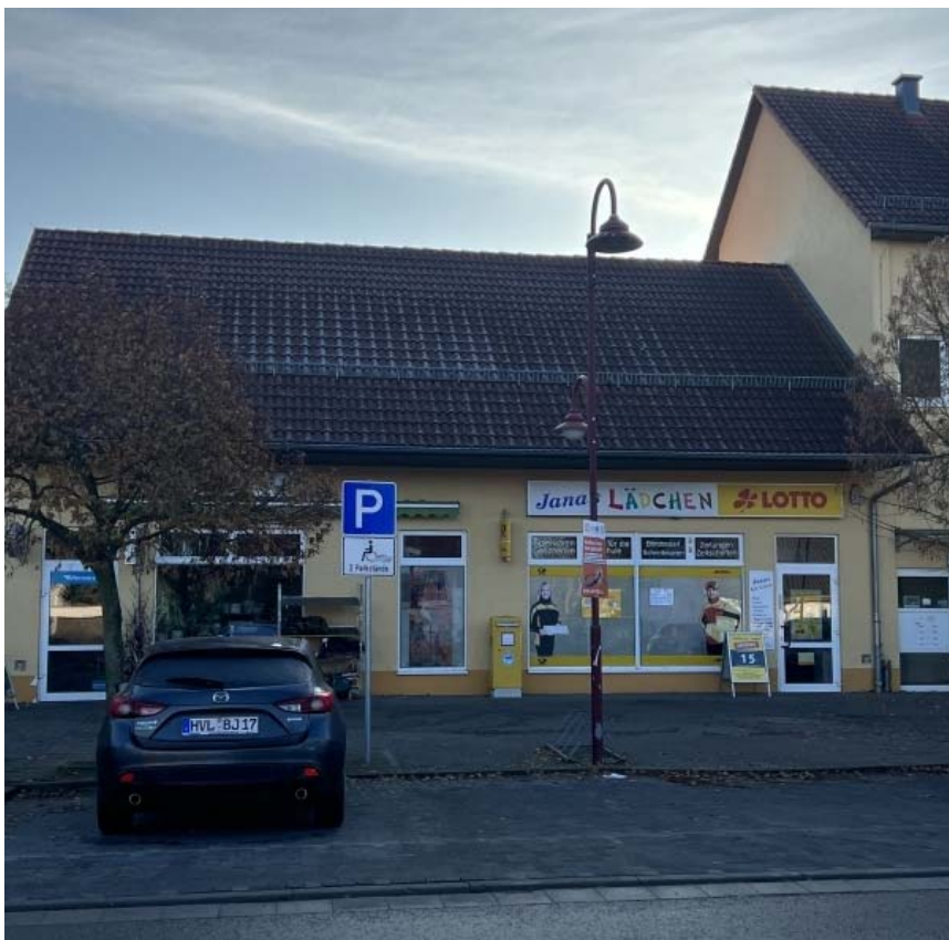
Foto 2: Dienstleistungsangebote im Bestand, die auch nach der baulichen Umgestaltung erhalten bleiben sollen
