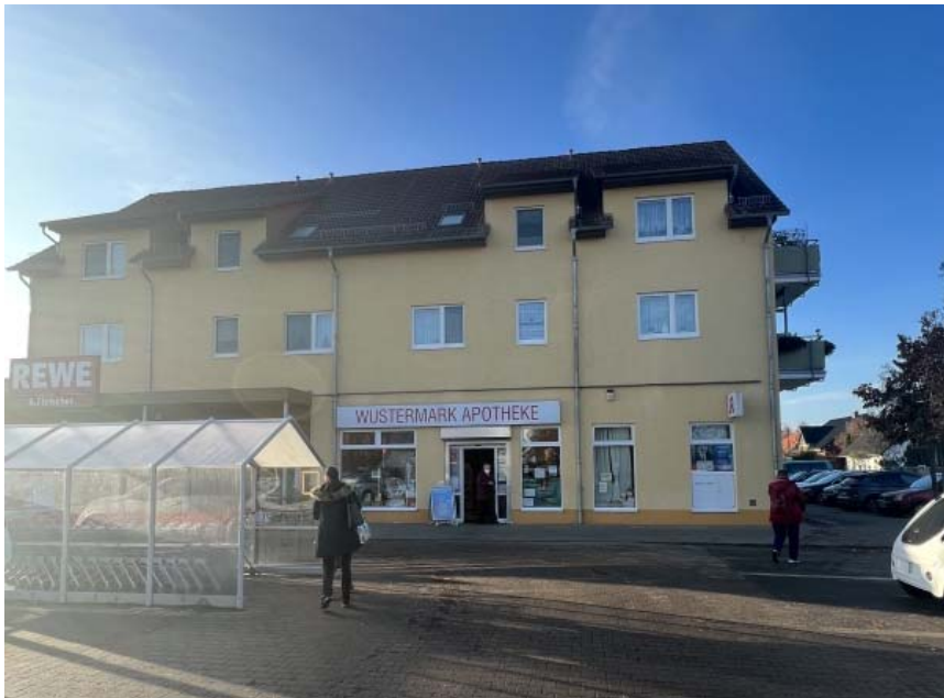
Foto 1: Wohn- und Geschäftshaus im Bestand, welches durch Anbauten erweitert werden soll
