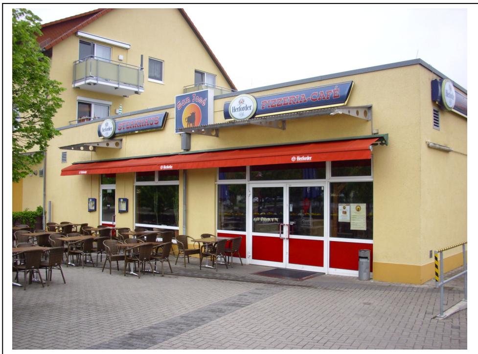
Foto 6: Blick auf das in den Gebäudekomplex integrierte Restaurant.
