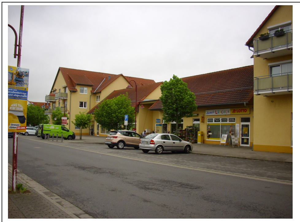
Foto 8: Blick auf den Gesamtkomplex zur Hoppenrader Allee.
