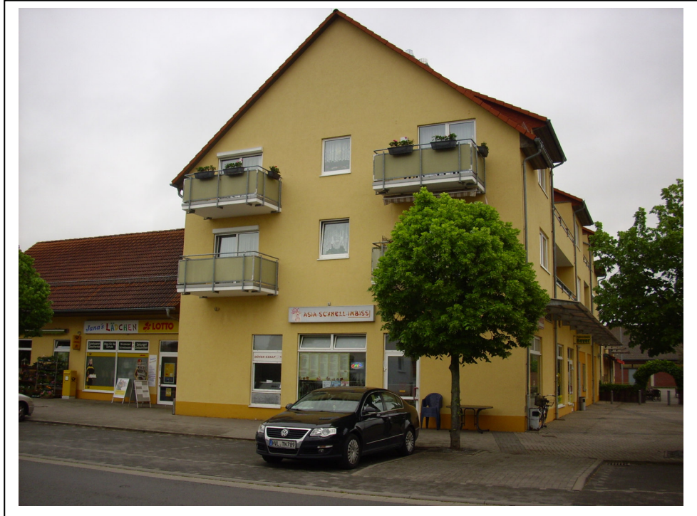
Foto 7: Blick auf das mehrgeschossige Wohngebäude im westlichen Gebäudeteil.
