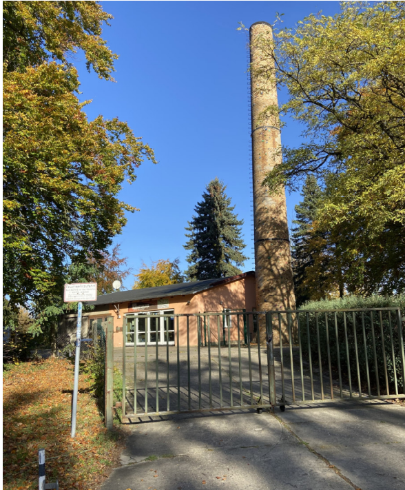
Abbildung 4: Altes Heizwerk (Blick von Süden)
