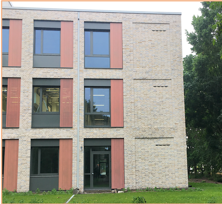
Abb. 35: Integration von Fledermaus- verstecken (Fledermauseinlaufblende 1FE) in das Gerty-Cory-Haus, Deutsches Institut für Ernährungs- forschung in Potsdam-Rehbrücke (Foto: DIfE 2021).
