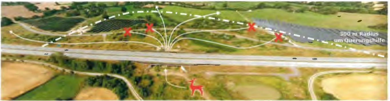
Abb. 2: Photovoltaik-Freiflächenanlagen (PV-FFA) in direkter Nähe einer Faunaunterführung. Wenn PV-FFA gezäunt und zu dicht an Querungshilfen oder an ungezäunten Straßen gebaut werden, kann die Funktionsfähigkeit der Querungshilfen erheblich beeinträchtigt oder gänzlich unterbunden werden, während die Unfallgefahr für Wildtiere zunehmen kann. Zum Vergleich mit Abb. 3 ist ein Radius von ca. 300 m westlich der Unterführung eingezeichnet (Quelle Luftbild: Björn Schulz).
