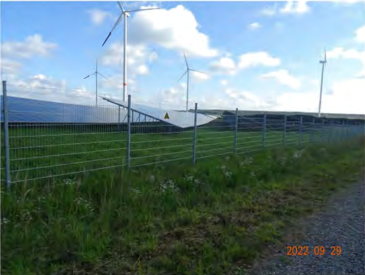
Beispiel einer PV-FFA mit 3 m Höhe (Foto uNB)
