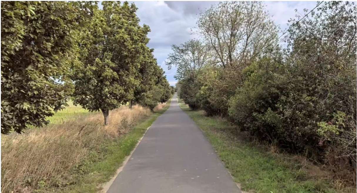
Abbildung 16: Aufnahme von OP S6 in Richtung Nordwesten - Quelle: Apple Maps
